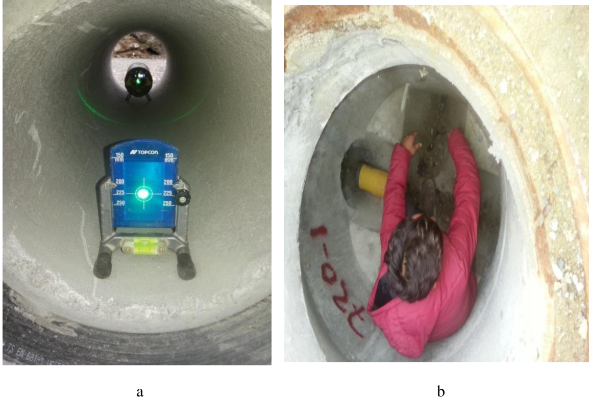
Resim 4.1. Lazer sisteminin beton boru (a) ve baca (b) içerisinde görüntüsü
