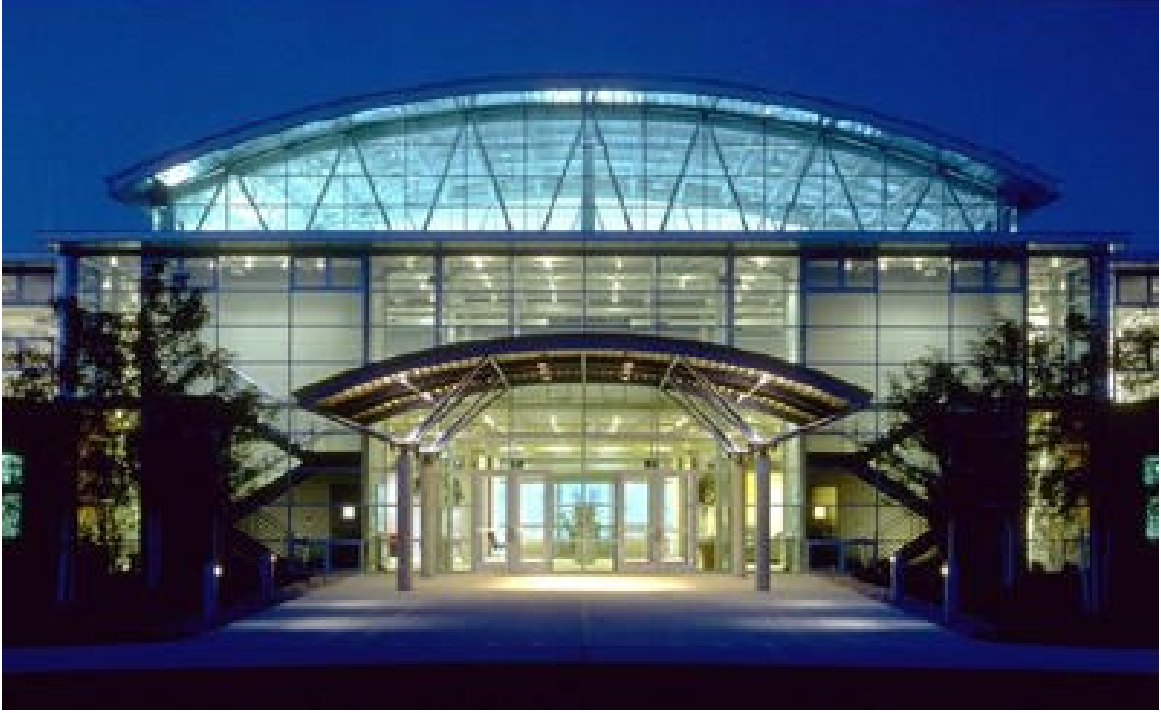
Resim 2.6. Herman Miller SQA binası (İnternet 10).
