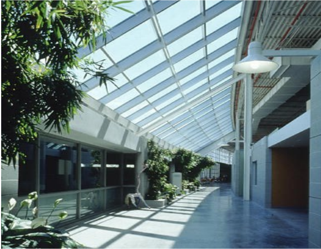
Resim 2.7. Gün ışığı sağlayan pencereler ile ofis ve üretim bölümlerini ayıran atrium (İnternet 10).
