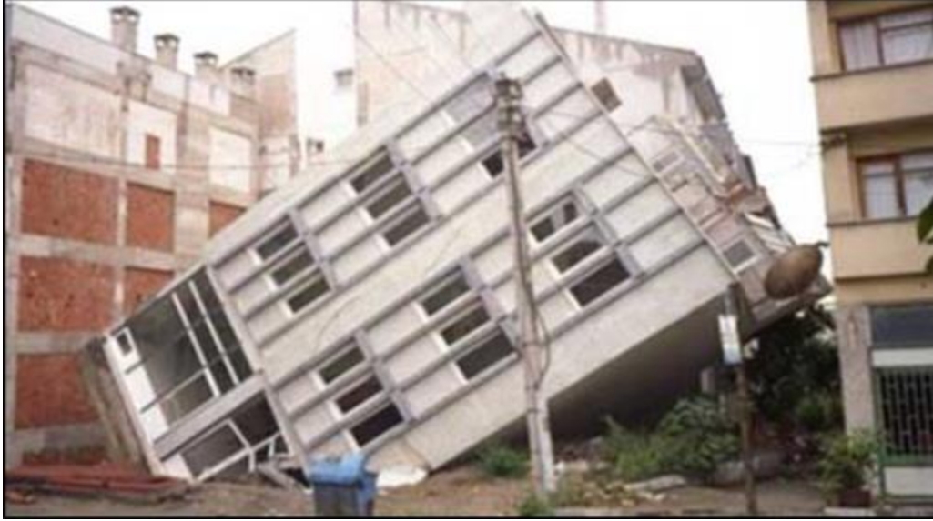
Resim 3.2. 1999 yılında Türkiye’de gerçekleşen İzmit Depremi sırasında oluşan sınıvlaşma örneği [73]
