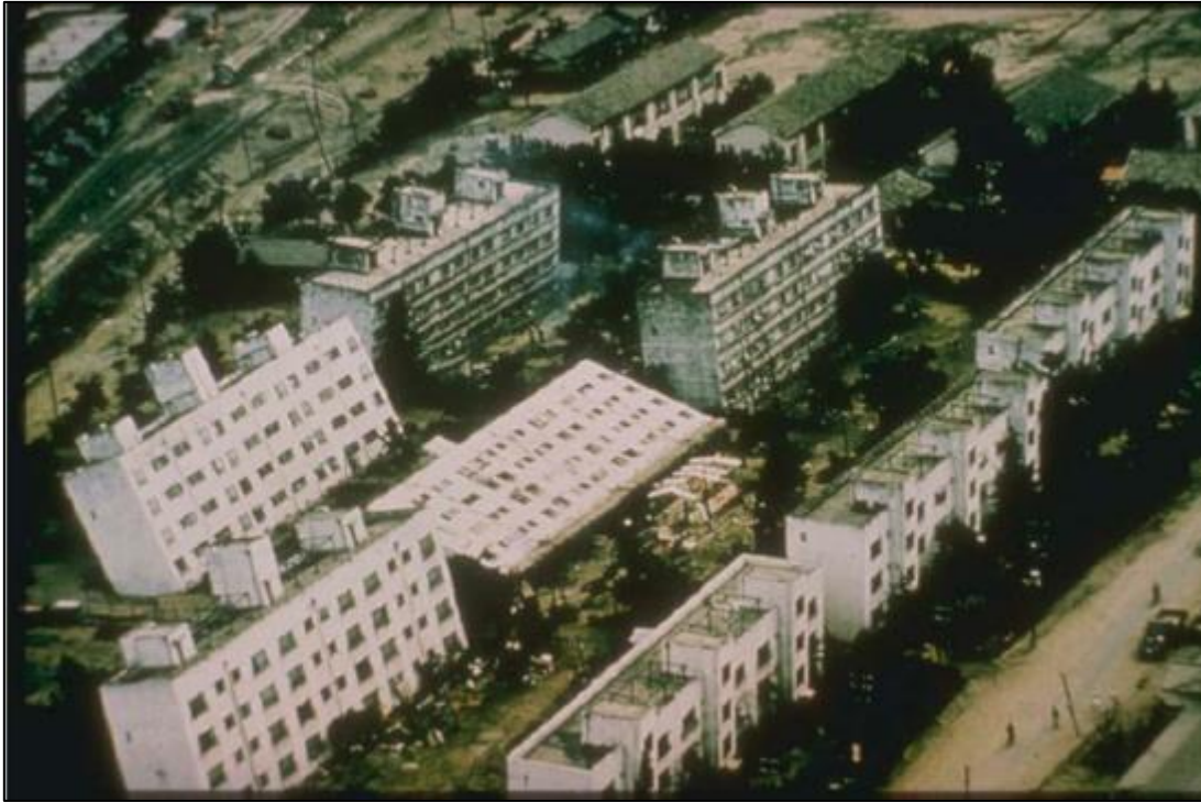
Resim 3.1. 1964 yılında Niigata (Japonya) kentinde gerçekleşen deprem sırasında zeminde oluşan sıvılaşmanın apartmanlara verdiği hasar [72]
