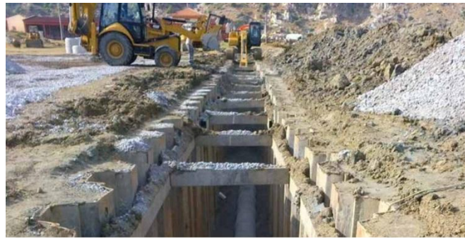
Resim 3.4. Aydın/ Sazlı Kanalizasyon İnşaatı (İller Bankası A.Ş. 2015 Faaliyet Raporu)
