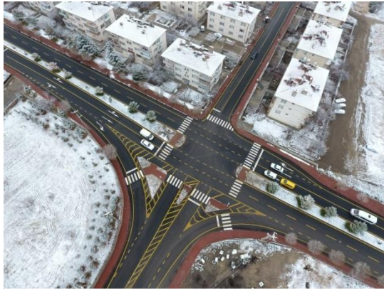
Resim 3.5. Nevşehir/ Ürgüp Yol Yapım İşi (İnternet: Ürgüp Belediyesi)
