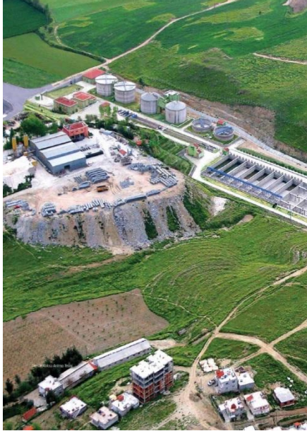
Resim 3.1. Denizli Atıksu Arıtma Tesisi (İller Bankası A.Ş. 2016 Faaliyet Raporu)
