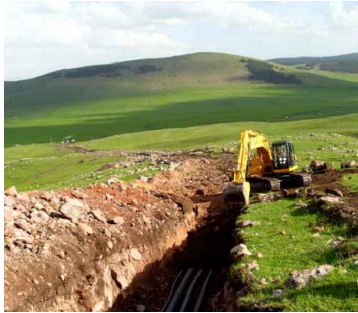
Resim 3.2. Ardahan/ Köprülü İçmesuyu İnşaatı (İller Bankası A.Ş. 2015 Faaliyet Raporu)
