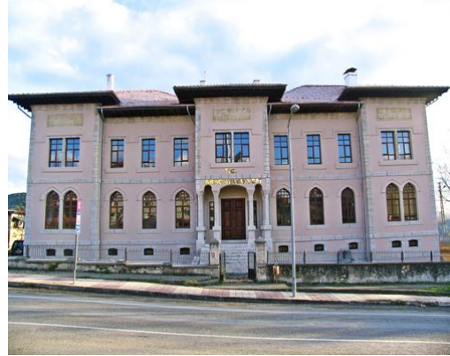
Resim 3.14. Kastamonu/ Araç Belediye Konağı Restorasyon (İnternet: Araç Belediyesi)
