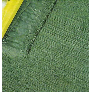
Resim 2.6. Çimento esaslı karışımın fırça yardımıyla yüzeye uygulanması [22]
