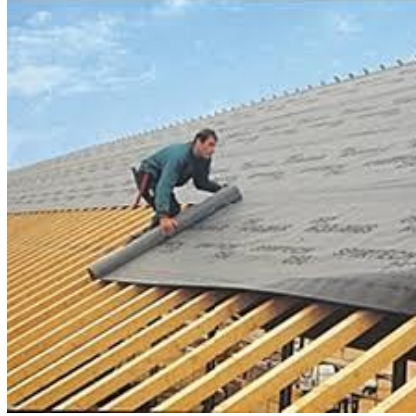
Resim 2.7. Buhar dengeleyici katman uygulanması [7]
