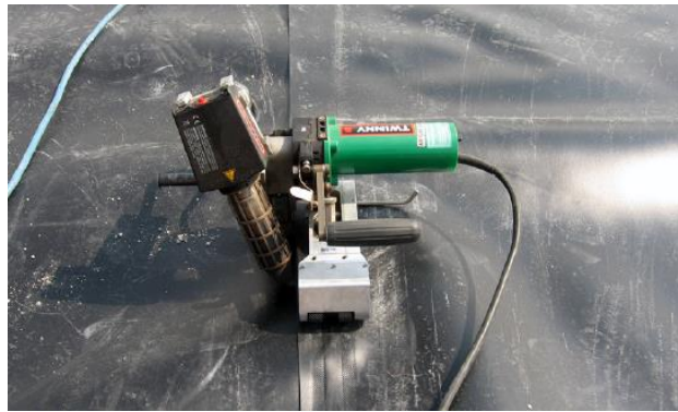
Resim 2.3. Plastik örtülerin robot kaynak makinesi ile kaynaklanması [22]
