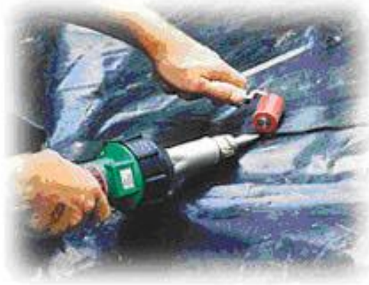
Şekil 2.6. Plastik örtülerin el fön makinesi ile kaynaklanarak birleştirilmesi [22]
