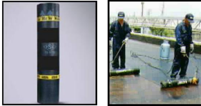
Resim 2.2. Polimer bitüm esaslı serme tip yalıtım malzemesinin yüzeye uygulanması [8]
