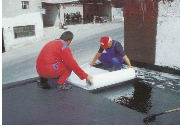
Resim 2.4. Yalıtım olarak kullanılan karışımın katları arasında taşıyıcı serilmesi [22]
