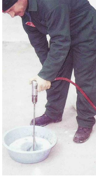
Resim 2.5. Çimento esaslı karışımın karıştırıcı ile karıştırılması [22]
