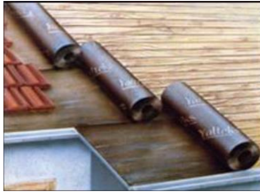
Resim 3.1. Kiremit altı örtüsünün döşenmesi [7]
