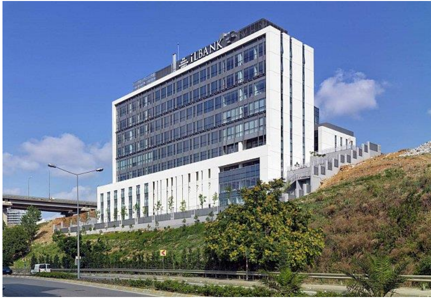
Resim 3.10. İller Bankası A.Ş. İstanbul Bölge Müdürlüğü Hizmet Binası (İnternet: Arkiv)
