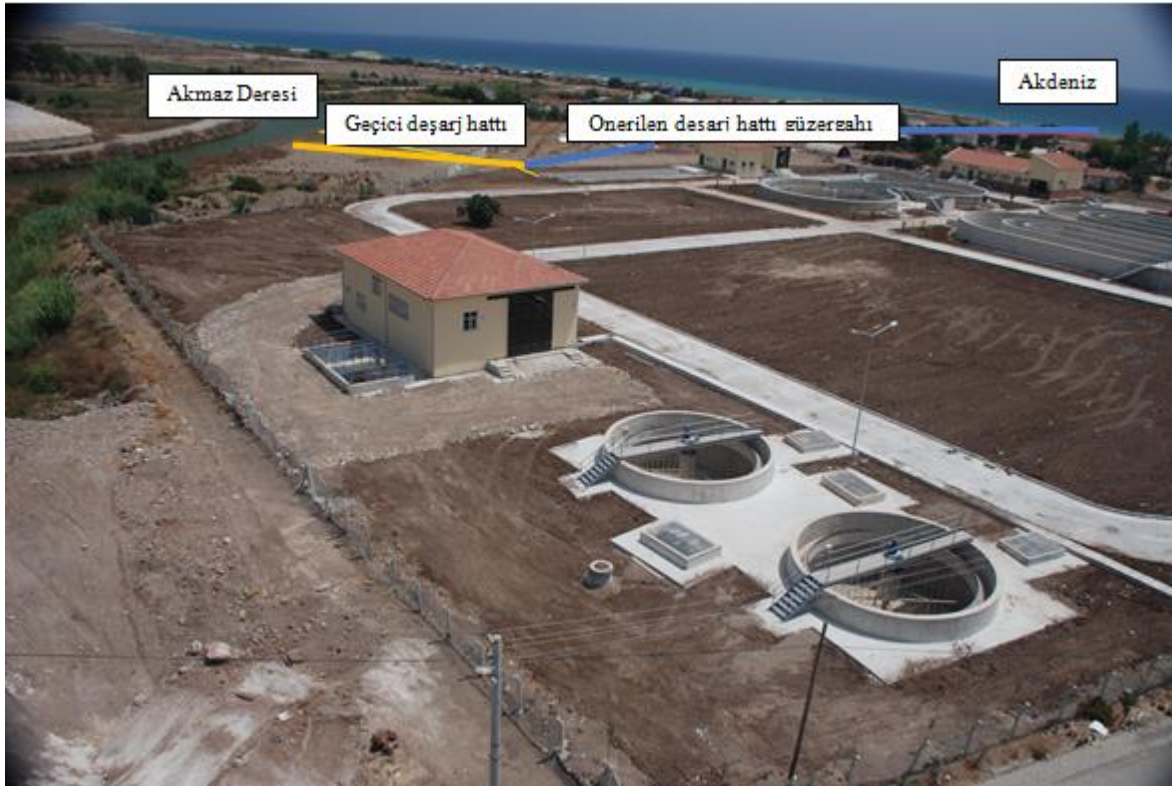
Resim 1.1. Kumluca Atıksu Arıtma Tesisi ile geçici deşarjı (sarı) ve etüt aşamasında önerilen deniz deşarjı kara hattı güzergahı (mavi) (İller Bankası, 2013a:17)
