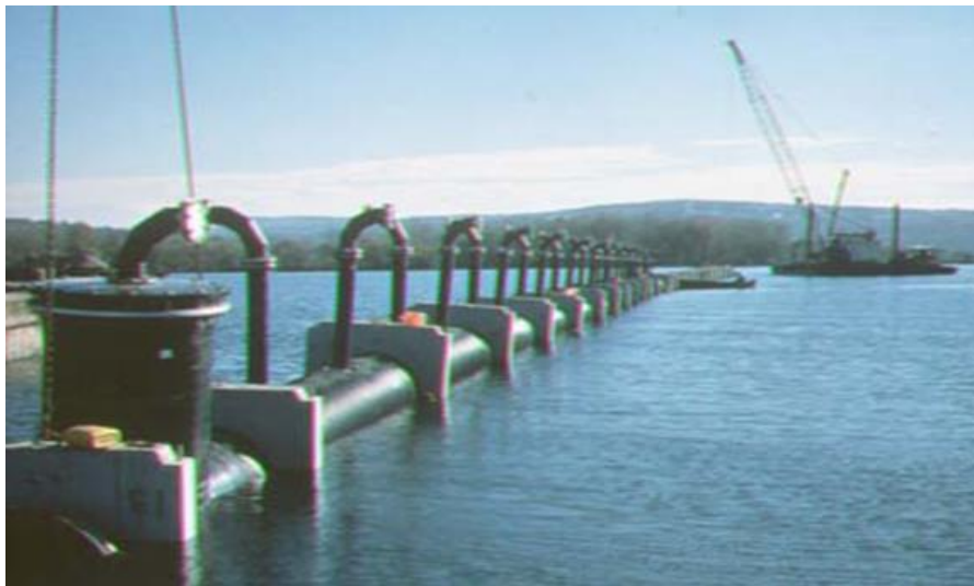
Resim 1.3. Yükselticili tip deniz deşarjı yayıcı (difüzör) örneği
