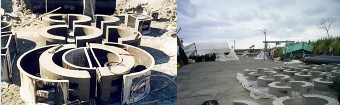
Resim 2.3. Beton ağırlık bloklarının dökülmesi (C. Yılmaz, 2006)
