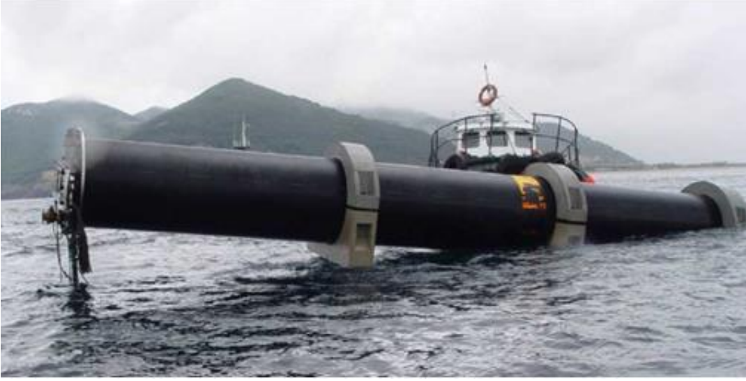
Resim 2.4. Batırma blokları monte edilmiş deşarj borusu (Berria, İspanya) (Pita, 2013:3)
