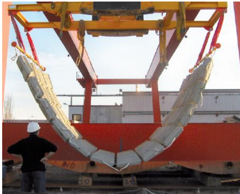
Resim 4.2. Şantiye sahasında bileşik beton blok örtü
