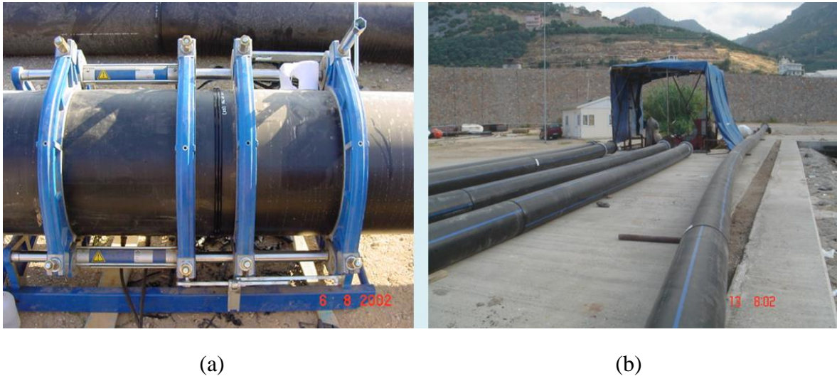
Resim 2.2. Kaynak makinesi ile işlem anında olan HDPE boru (a) ve boru imalat boylarının kaynaklanarak gereken ano boyuna getirilmesi (b) (C. Yılmaz, 2006)
