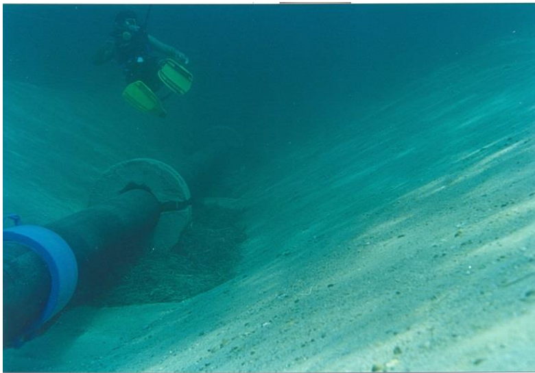
Resim 2.7. Deşarj hattının dalgıç kontrolünde izlenmesi (C. Yılmaz, 2006)
