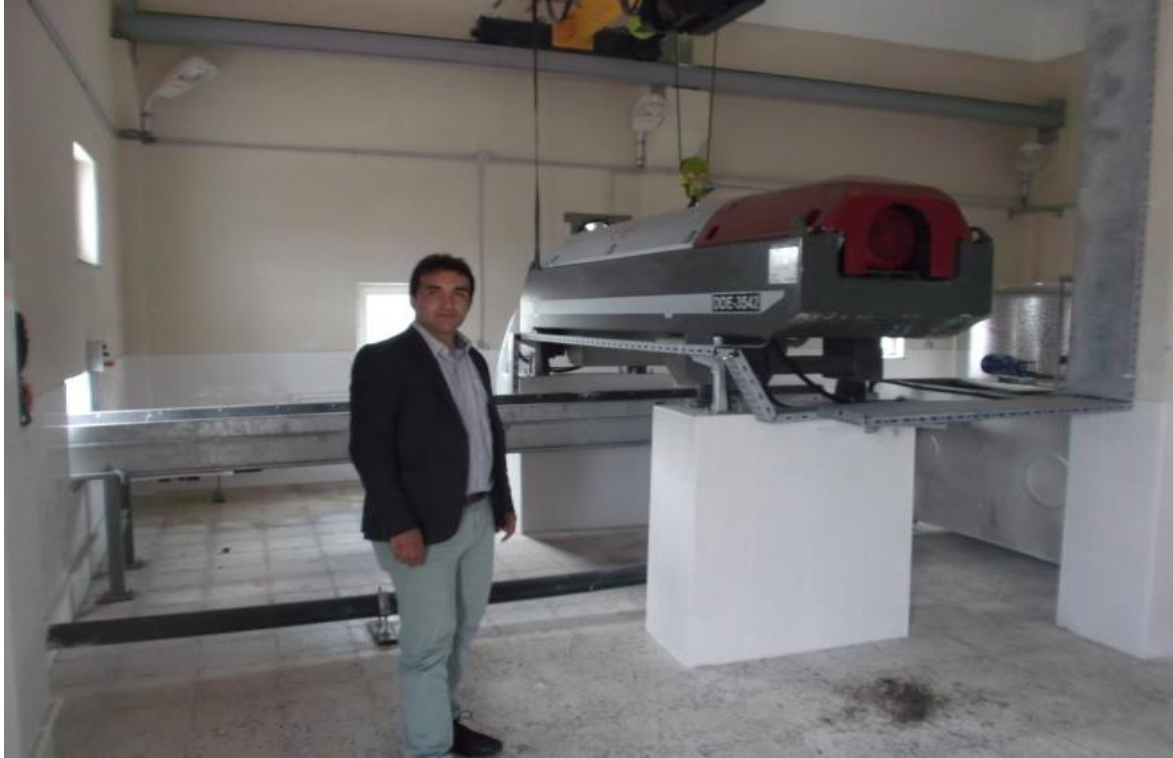
Resim 6.3.Kelkit AAT dekantör ve polielektrolit dozlama ünitesinden görünüm
