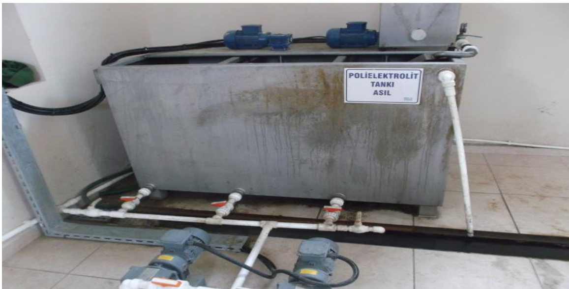
Resim 6.2. Gümüşhane AAT polielektrolit dozlama ünitesinden görünüm
