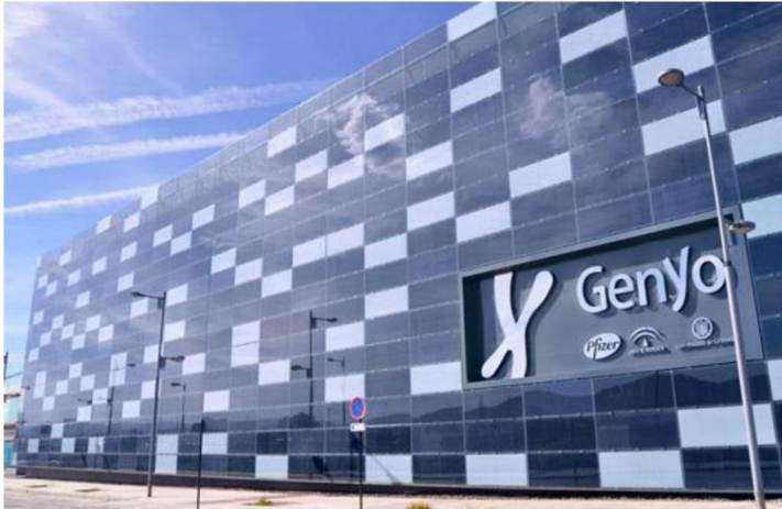
Resim 3.4. Bina cephesinde kullanılan bütünleşik panel uygulaması [45]
