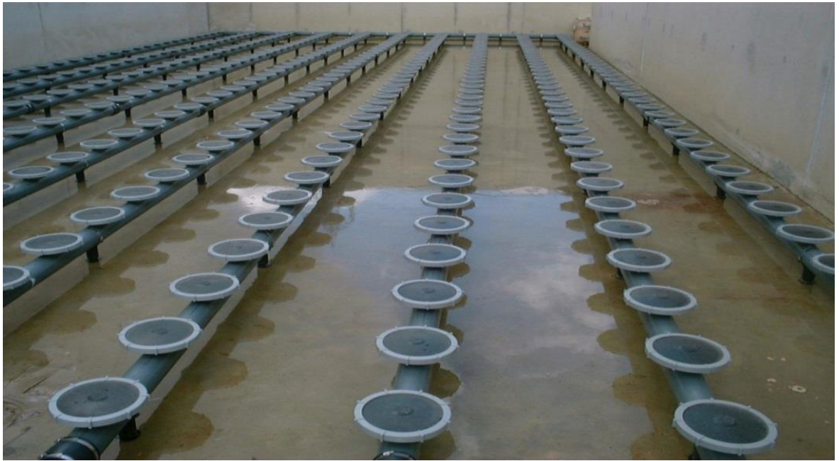
Resim 4.11. Difüzörlü havalandırma sisteminde ince gözenekli disk difüzörler [33]
