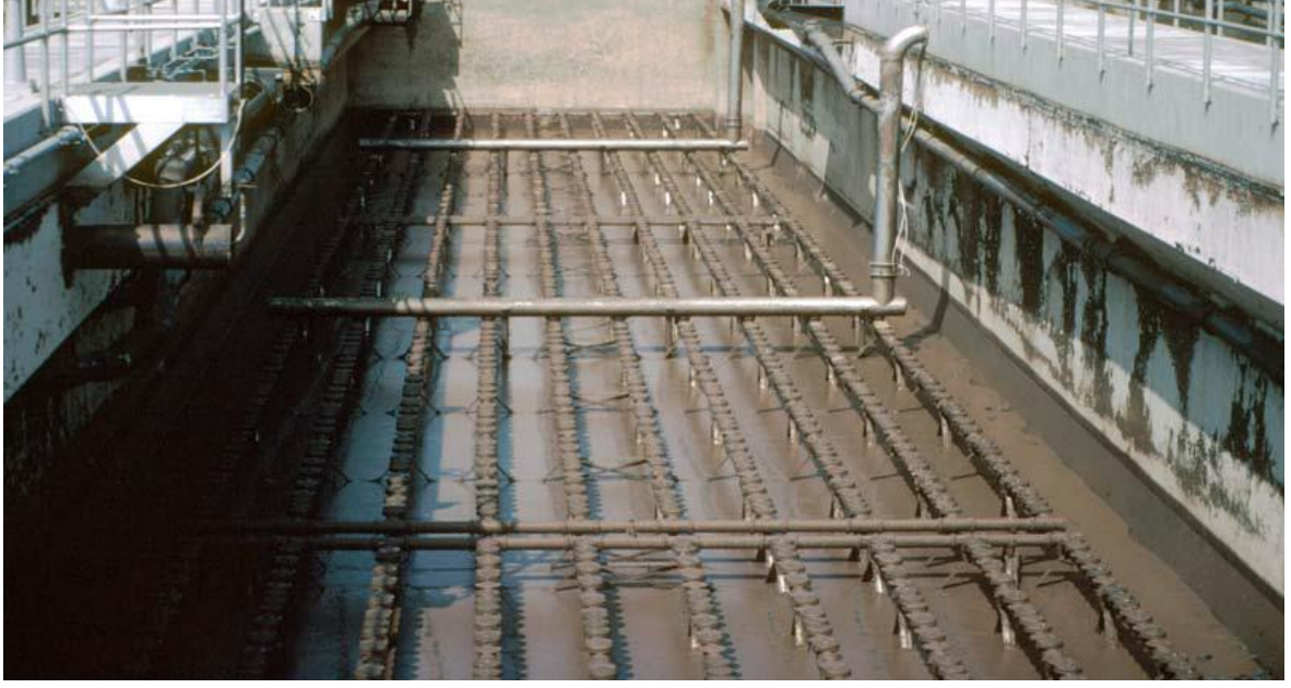
Resim 4.14. Kirlenmiş difüzörler [33]
