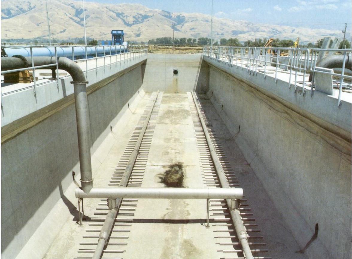
Resim 4.7. Çift taraflı ortada spiral difüzör sistemi [33]
