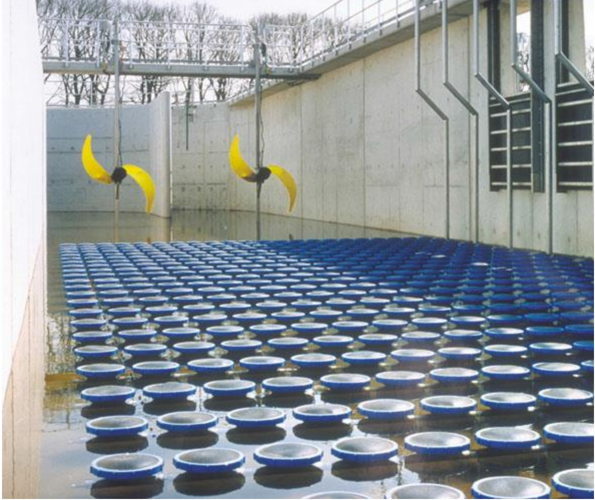
Resim 4.16. Örnek bir tesiste ince gözenekli difüzörler ve karıştırıcıların konumu
