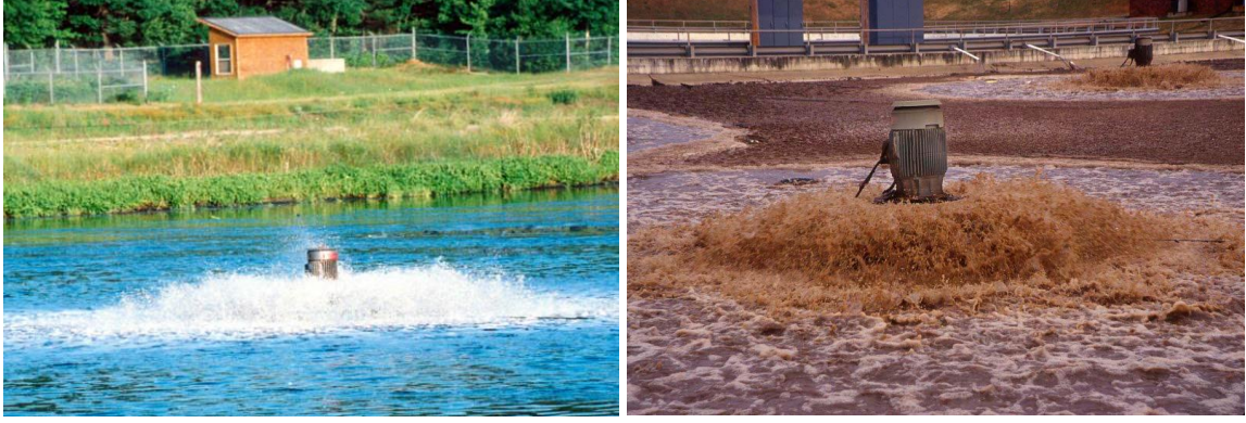
Resim 4.23. Yüksek hızlı yüzeysel havalandırıcılar [26]
