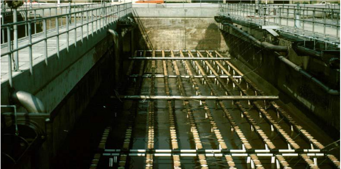
Resim 4.15. Temizlenmiş difüzörler [34]
