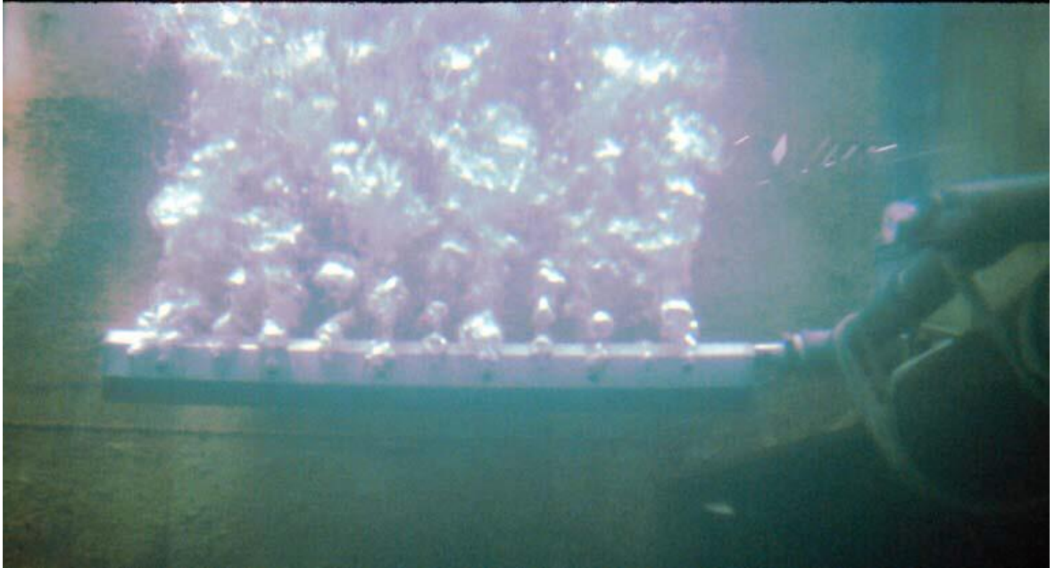
Resim 4.10. Su altında kaba kabarcıklı difüzör sistemi [33]
