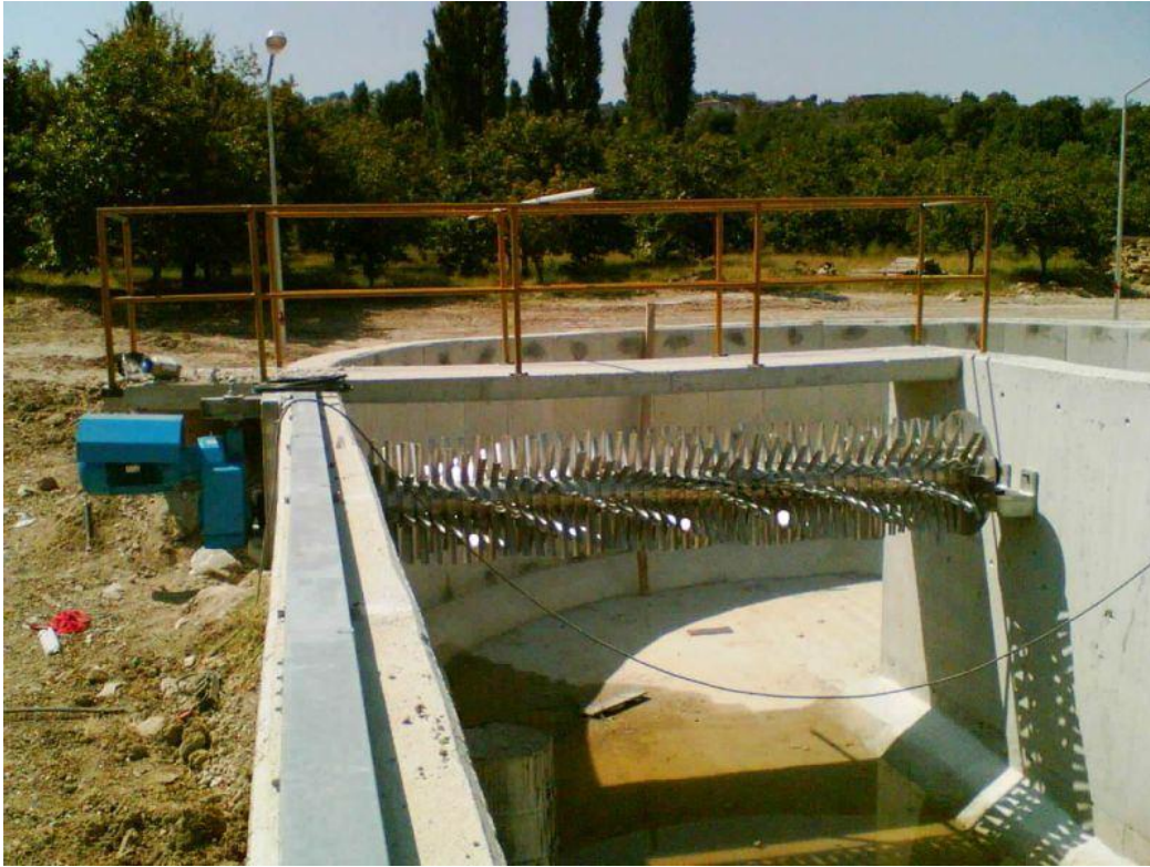
Resim 4.27. Yatay milli havalandırıcı [47]
