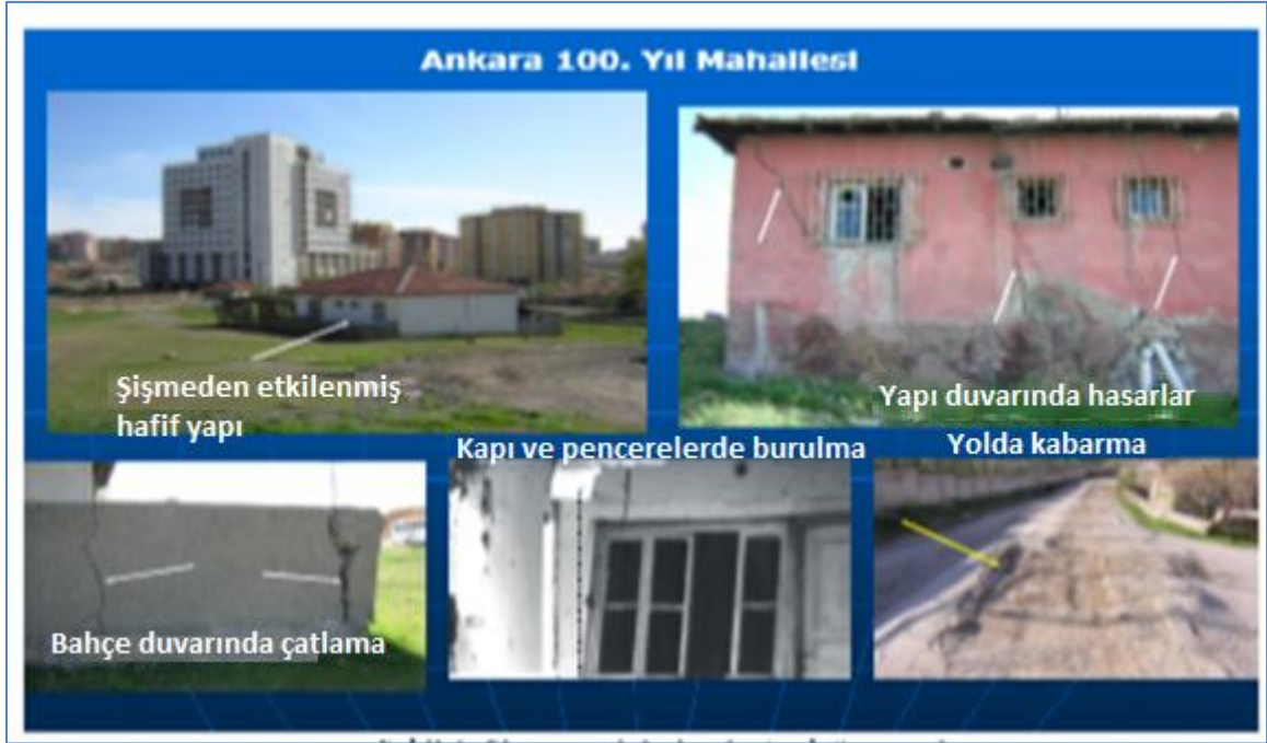
Resim 3.2. Şişen zeminlerin oluşturduğu zararlara örnekler (Avşar ve diğerleri, 2009)
