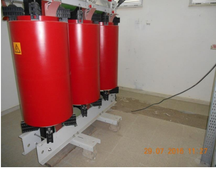
Resim 4.16. Erciş (VAN) otopar yapım işi 630 kVA trafoda işletme topraklaması
