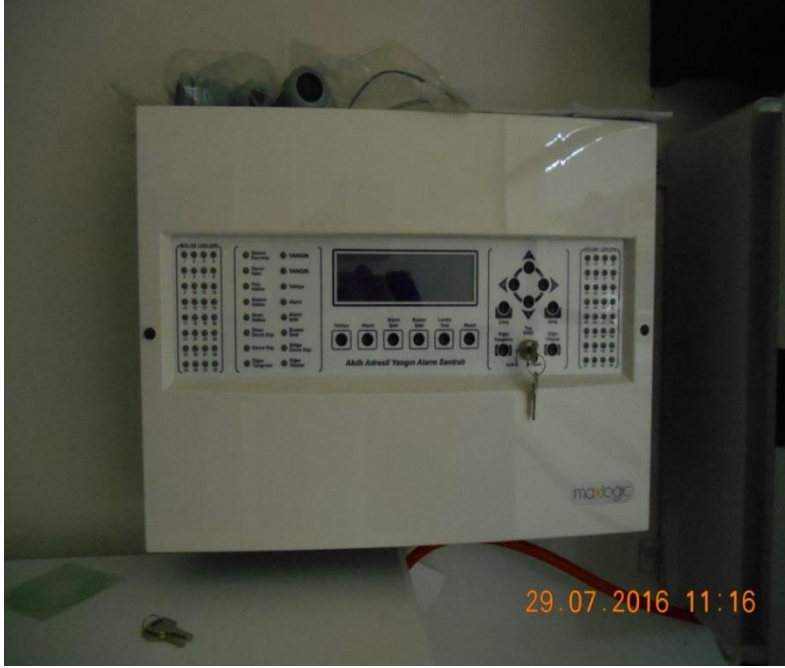
Resim 4.12. Erciş (VAN) otogar işinde kullanılan akıllı adresli yangın algılama ve ihbar santrali
