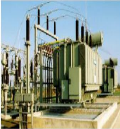
Resim 4.6. Trafoda bulunan parafudrun konumu [6]
