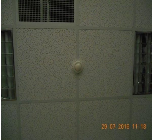
Resim 4.13. Erciş (VAN) otogar işinde kullanılan kombine dedektör
