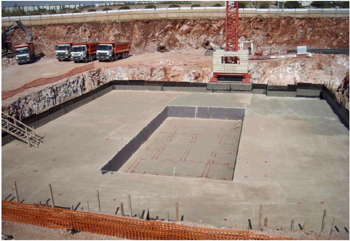
Resim 5.1. Uygulanan su yalıtımı (1).
