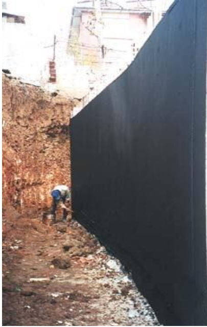
Resim 3.1. Asfalt emülsiyon uygulamaları.
