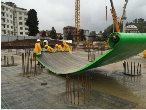
Resim 3.6. Bentonit şilte uygulaması.
