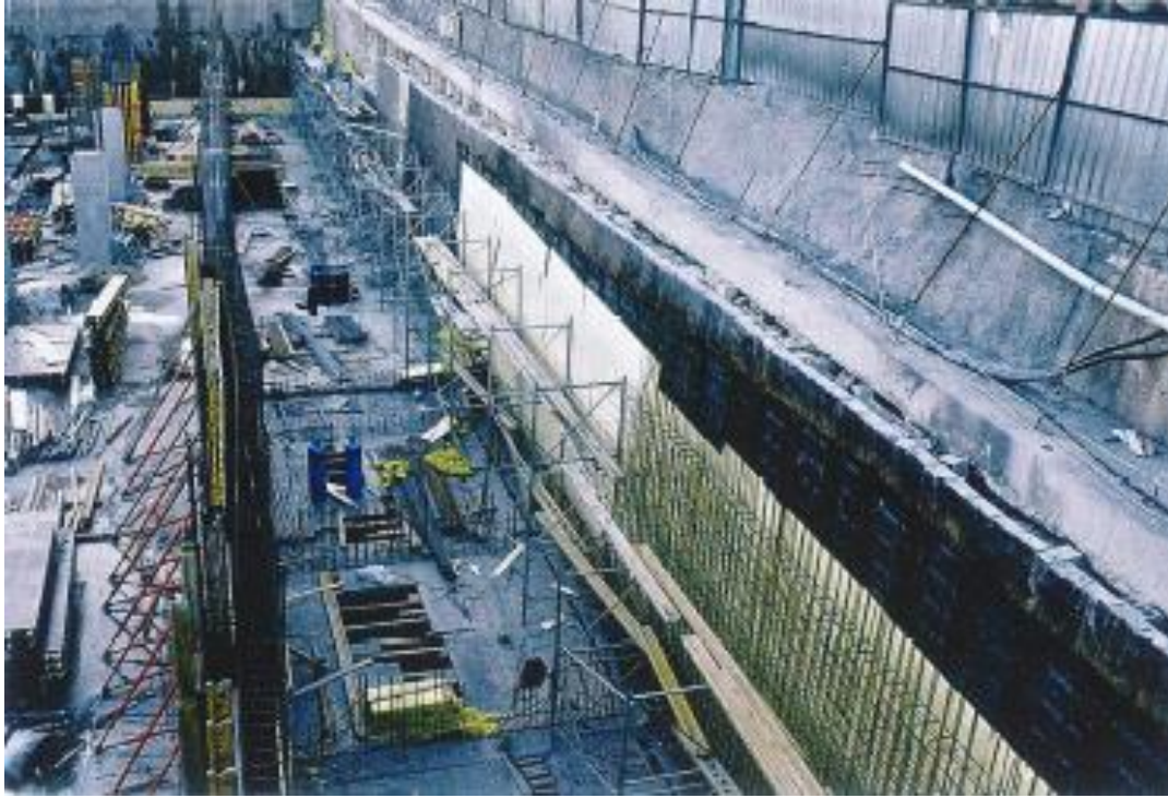
Resim 4.1. İçten bohçalama, doğru uygulama.
