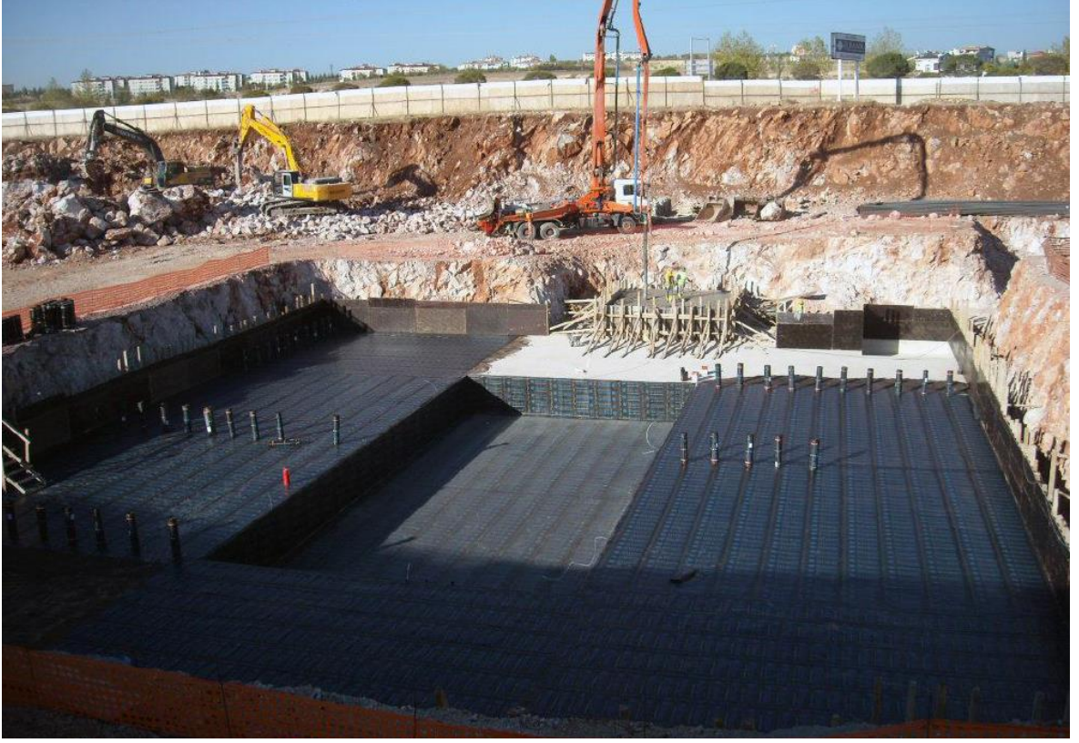
Resim 5.2. Uygulanan su yalıtımı (2).
