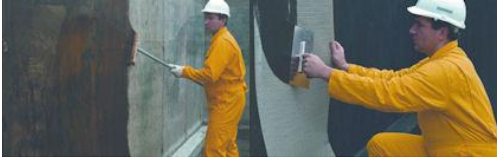
Resim 3.3. Bitüm esaslı sürme tip su yalıtım malzemesi (kalın).
