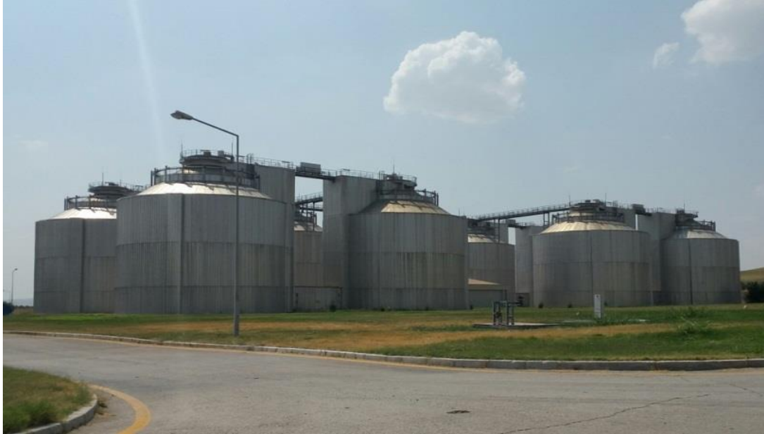
Resim 4.5. Tatlar AAT çamur özümleme tankları
