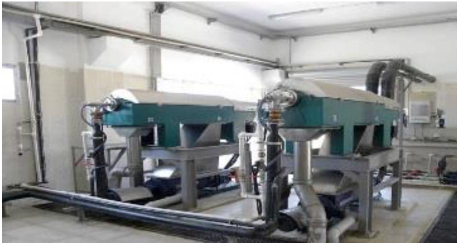
Resim 2.7. Çamur susuzlaştırma ünitesi [16]
