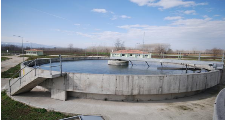
Resim 2.6. Ön çökeltim havuzu [18]
