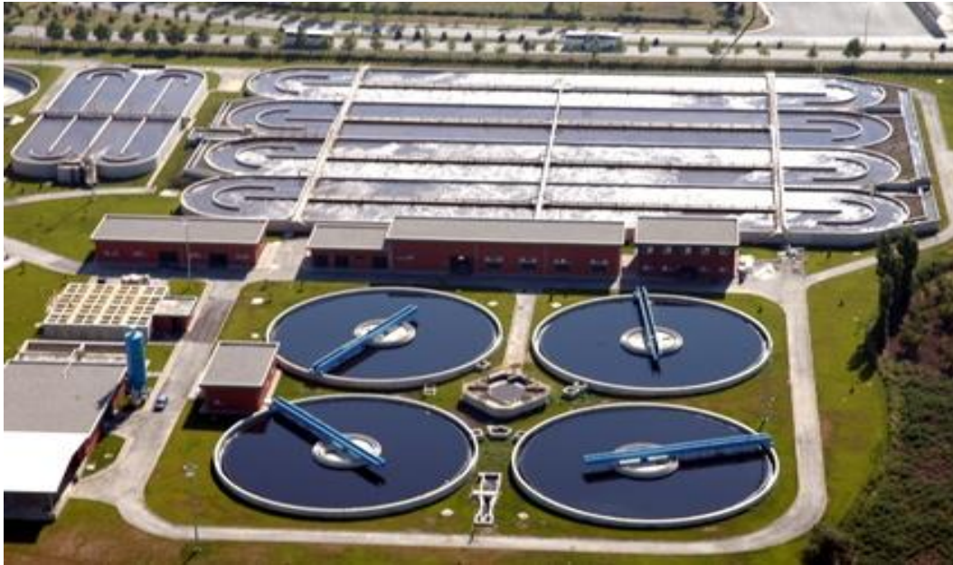
Resim 2.1. Dosab atıksu arıtma tesisi [12]
