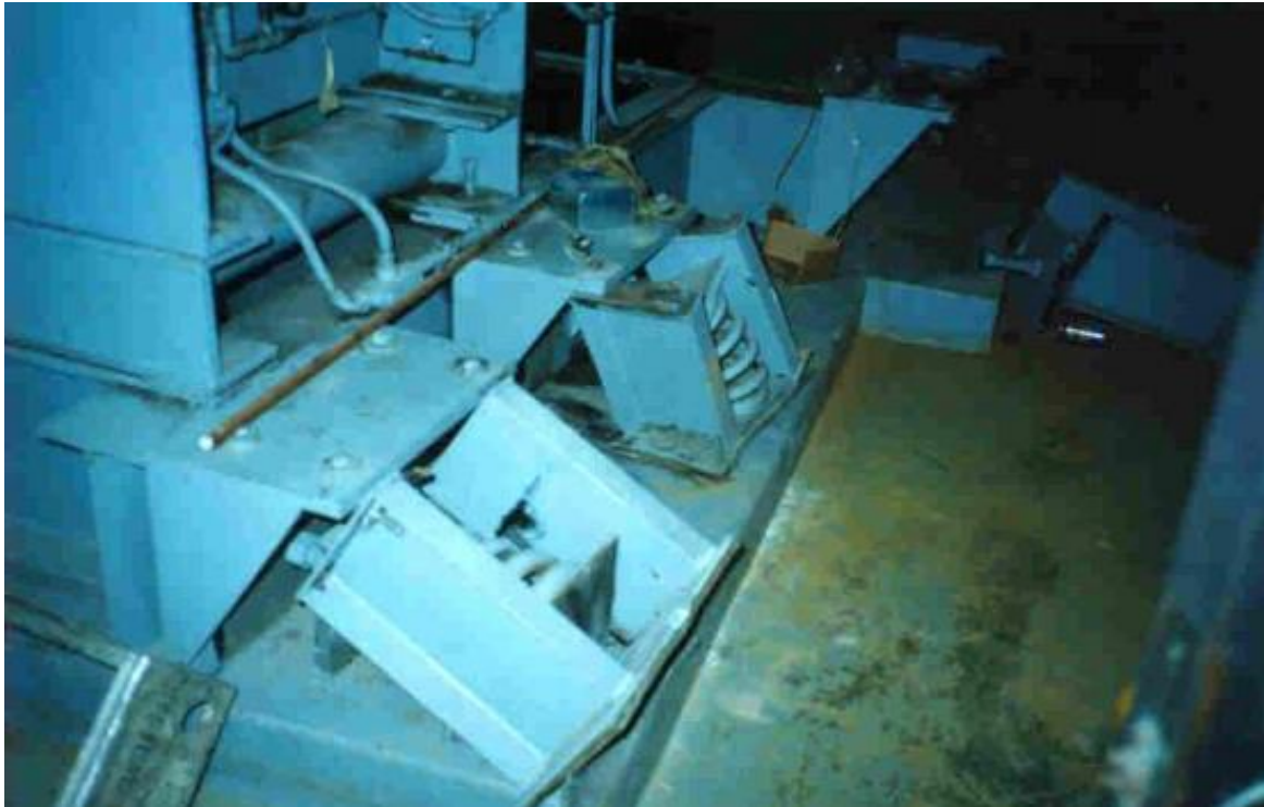
Resim 2.6. Hatalı monte edilmiş sismik sınırlayıcı [6]
