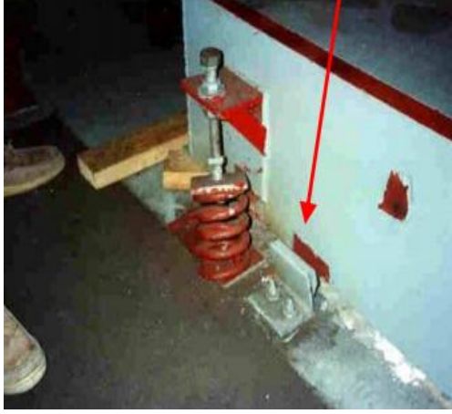
Resim 2.5. Hatalı boyutlandırılmış sismik sınırlayıcı [6]
