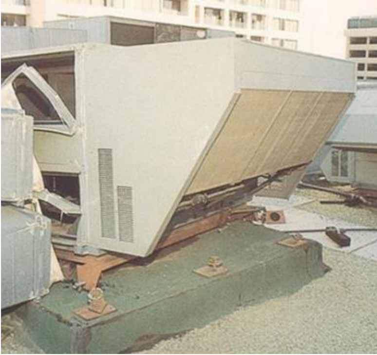
Resim 2.4. Sismik sınırlayıcı olmayan titreşim izolatörü kullanımı [6]
