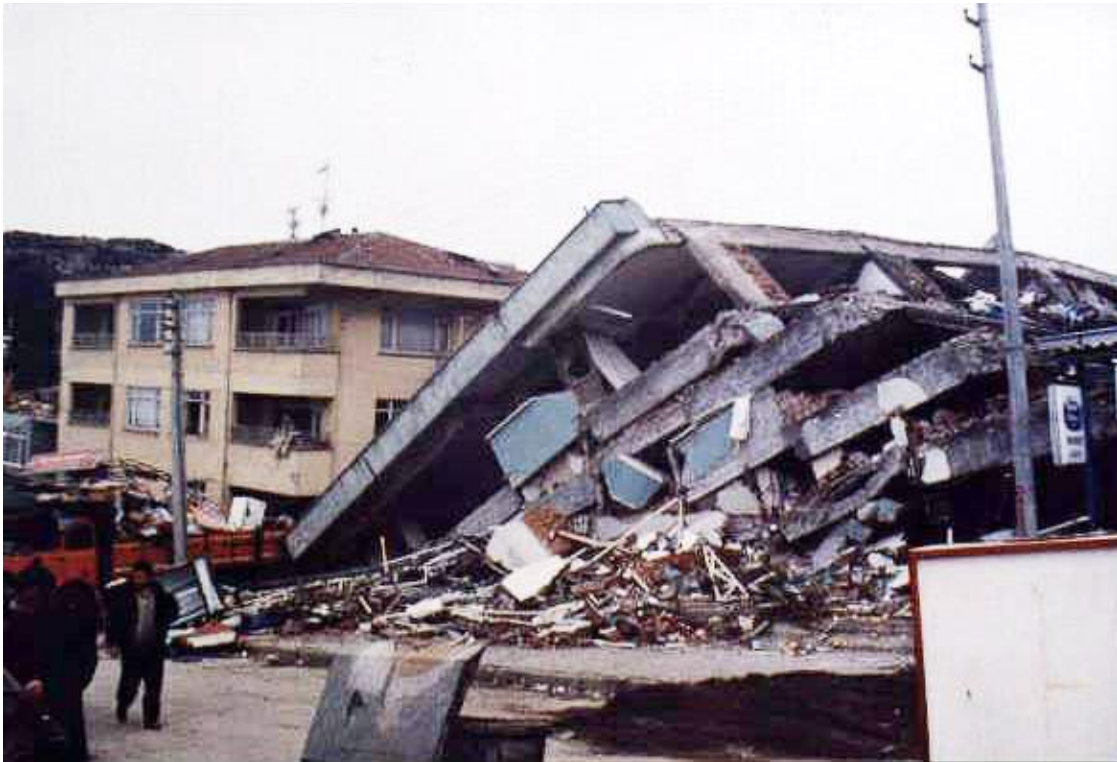
Resim 2.1. Depreme dayanıksız bir bina [5]
