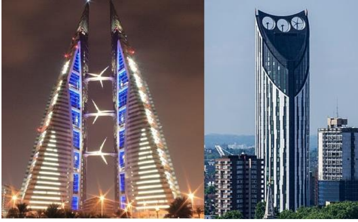
Resim 2.12. Bina entegre rüzgâr türbini örnekleri
