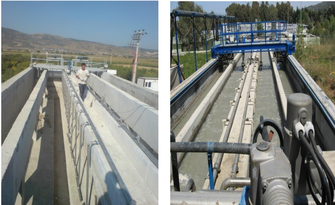
Resim 1.1. Havalandırılmalı kum ve yağ tutucu görünümü (Damla Çevre, 2016)
