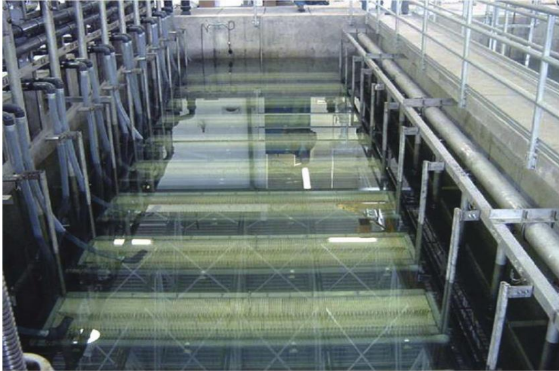
Resim 2.2. Batık tipli membran görünüşü (The Mcilvaine Company, 2016)
