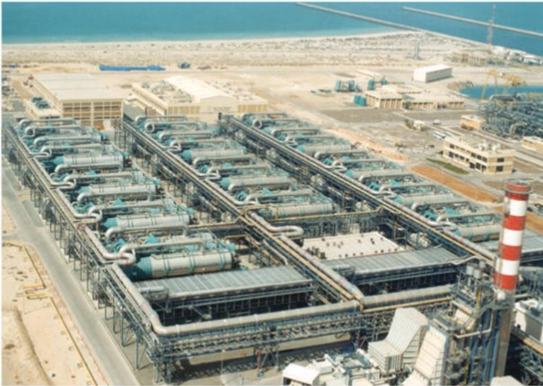
Resim 2.1. Abu Dhabi ters osmoz tuzsuzlaştırma tesisi (Aslan, 2016: 92)
