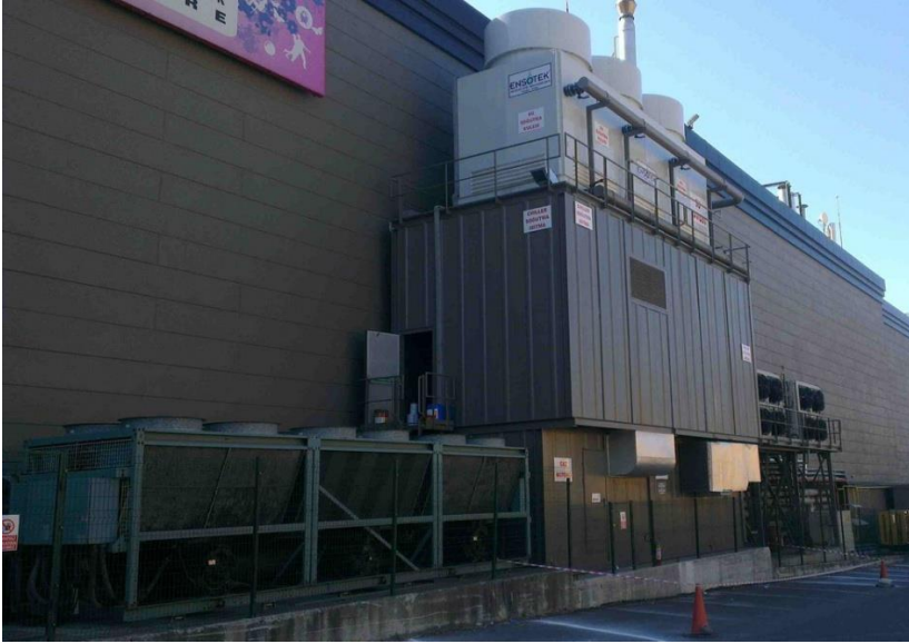
Resim 2.2. Doğalgaz ile çalışan 1,2 MW'lık güçte ORION AVM trijenerasyon tesisi
