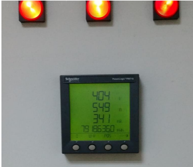
Resim 4.5. Ölçüm esnasında MCC-2B analizörü (Yazar tarafından fotoğraflanmıştır)
