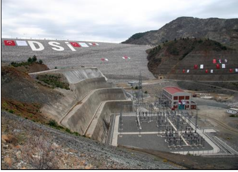
Resim 1.4. Dalaman Akköprü Barajı [11]
