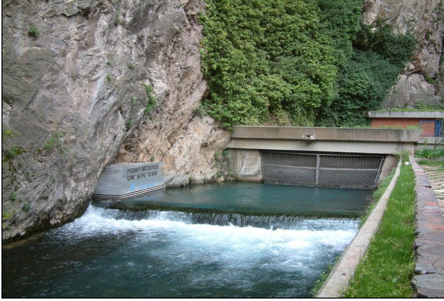
Resim 1.5. Pozantı (Adana) Belediyesi içme suyu kaynağı [12]
