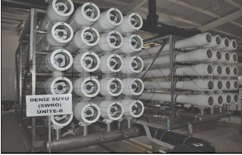
Resim 1.3. Avşar Belediyesi deniz suyundan içme suyu elde eden ünite [10]
