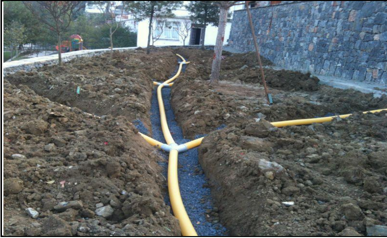
Resim 1.9. Drenaj borularıyla fazla suyun toplanması [16]
