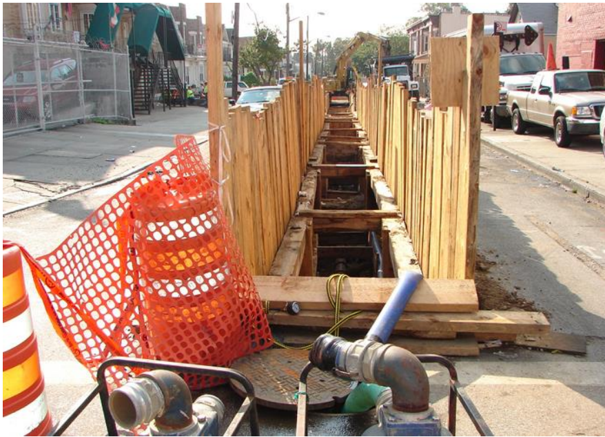
Resim 2.1. Tam kaplamalı ahşap iksa uygulaması (Bancker Corporation:2016)
