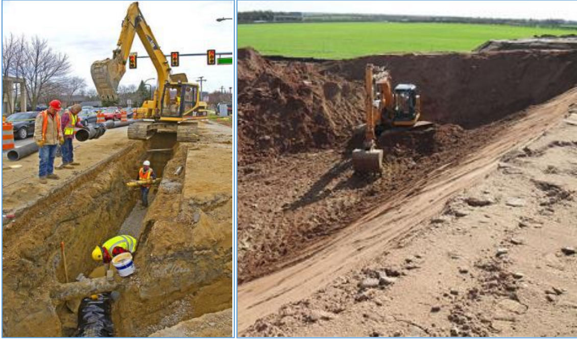
Resim 3.1. Hendek kazısı örnekleri (ÇSGB, 2016: 12)
