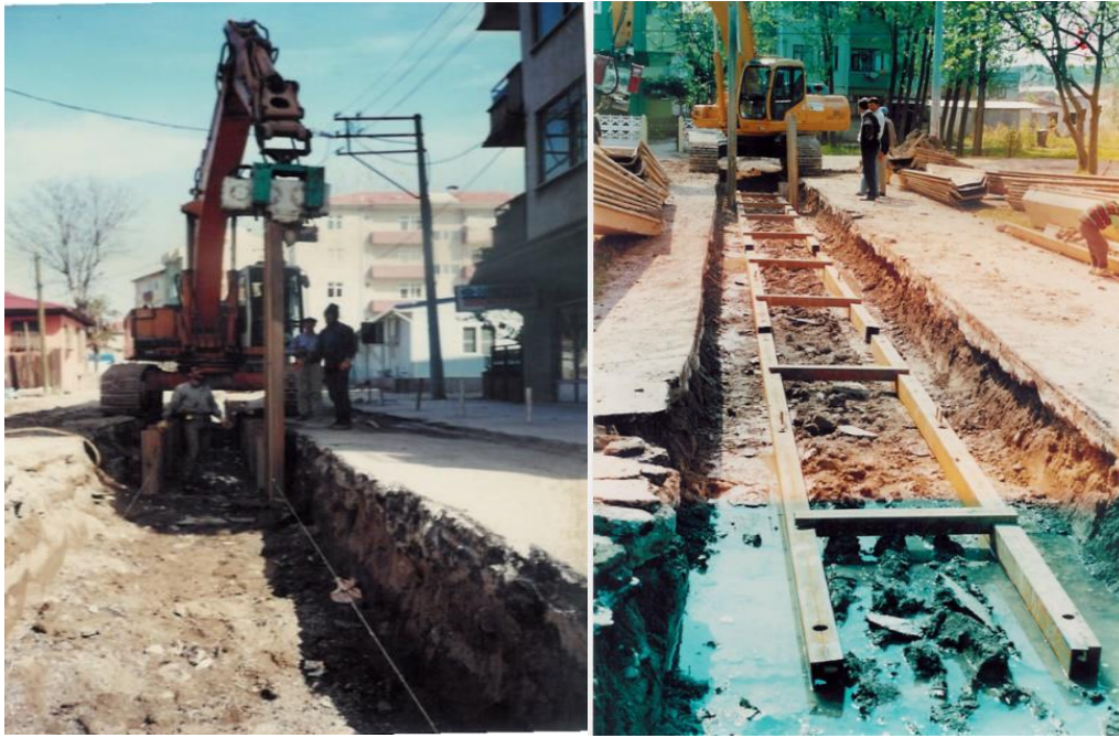
Resim 2.3. Önkazı ve palplanş çakım hattının belirlenmesi (Danacı, 2009: 6)
