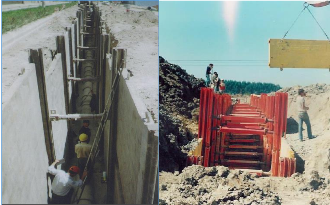
Resim 2.2. Çelik pano iksa uygulaması (Danacı, 2009: 5) ve (Aşçı, 2012: 18)
