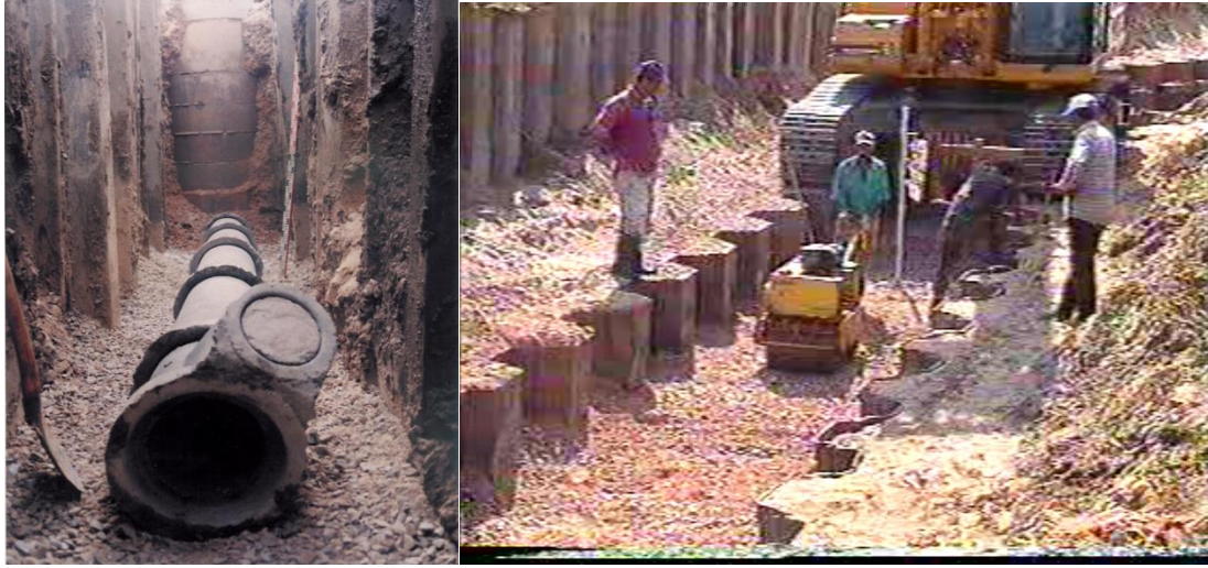
Resim 2.4. Palplanş içinde hat ve tabakalar halinde sıkıştırma işlemi (Danacı, 2009: 7)
