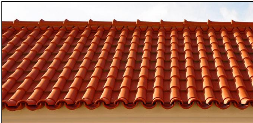
Resim 3.4 . Kiremit çatı örtüsü (internet 22)
