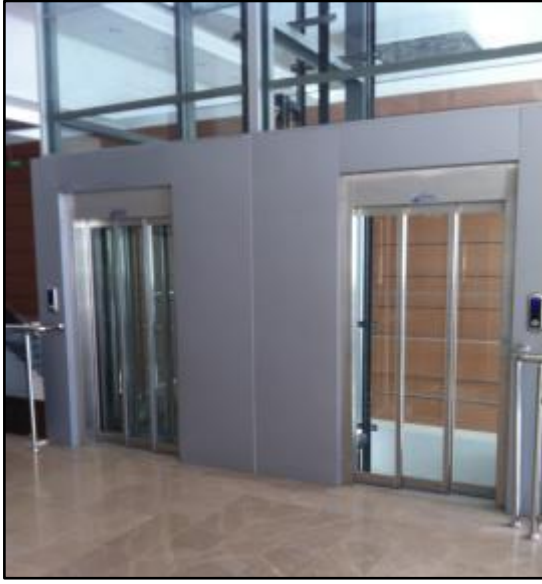
Resim 4.17. Hanımlar Kültür Merkezi tekerlekli sandalyeli kullanımı için uygun asansör örneği (yazarın arşivinden)
