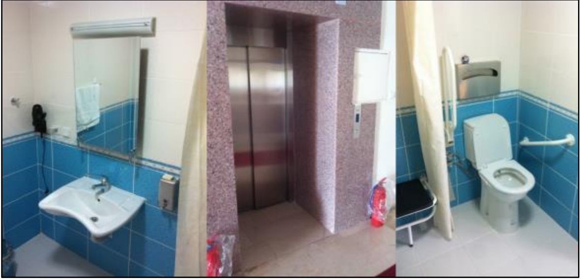
Resim 3.5. Sivas Bölge Müdürlüğü sosyal tesisleri bakım ve onarım işinde engelli düzenlemeleri (yazarın arşivinden)
