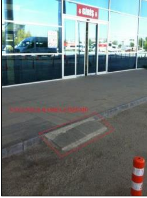
Resim 4.26. Sivas otobüs terminali girişinde rampa örneği (yazarın arşivinden)
