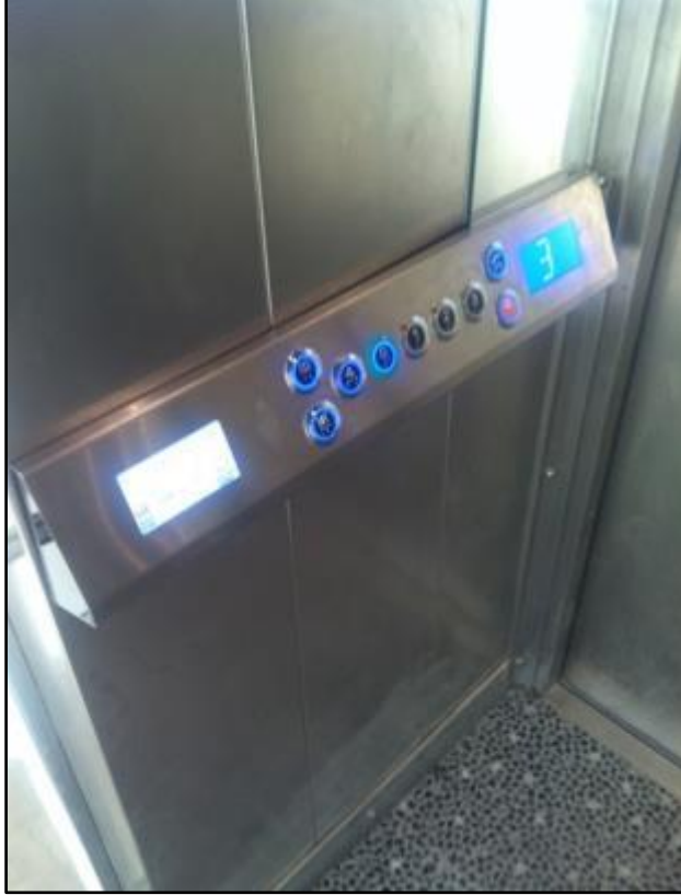
Resim 4.4. Tokat İl Özel İdaresi idari binası engelli asansörü paneli (yazarın arşivinden)
