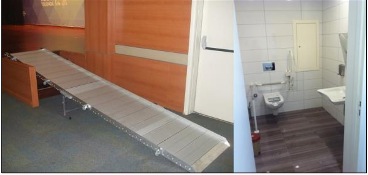
Resim 3.3. Erbaa kongre ve kültür merkezi yapım işi engelli düzenlemeleri (yazarın arşivinden)
