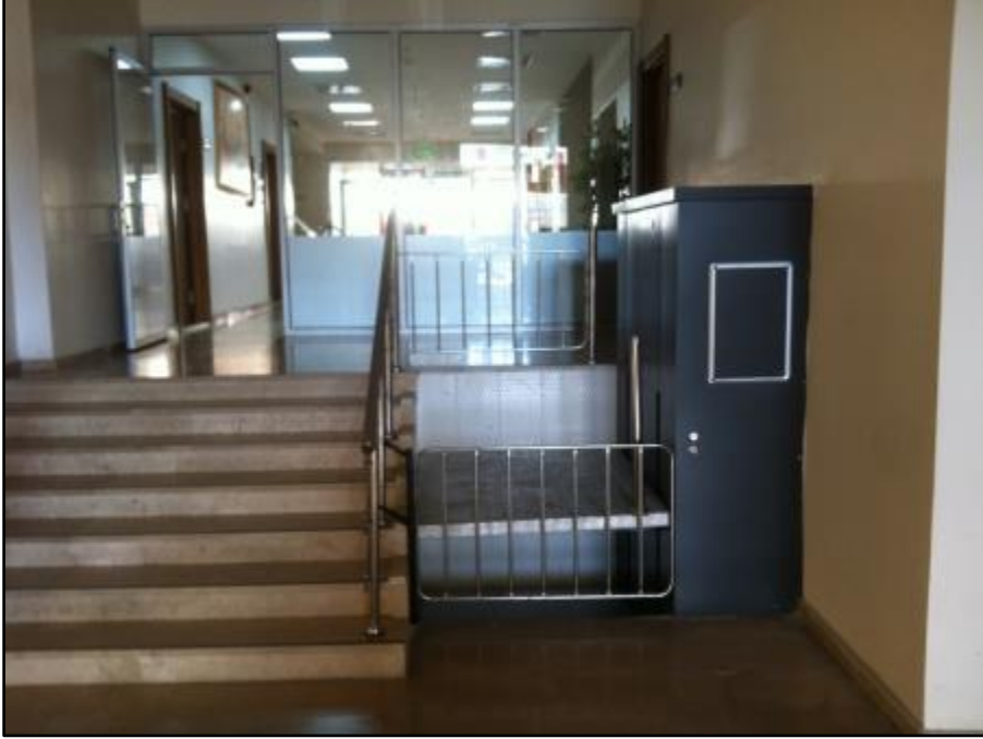
Resim 4.21. Hanımlar Kültür Merkezi engelli platformu örneği (yazarın arşivinden)
