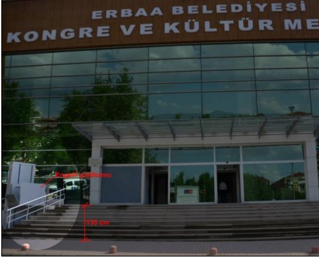
Resim 4.5. Erbaa (Tokat) Belediyesi K lt r Merkezi'nde engelli platformu
