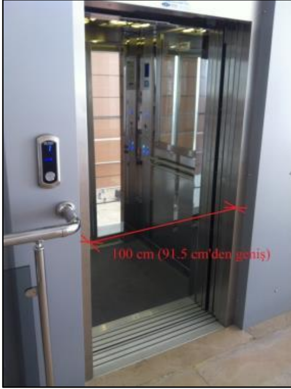
Resim 4.19. Hanımlar K lt r Merkezi uygun asans r kapı geniřlięi (yazarın arřivinden)
