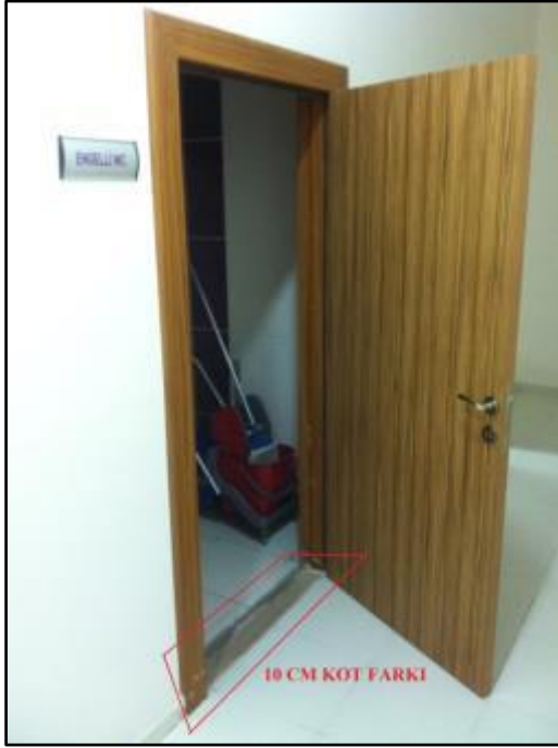
Resim 4.23. Hanımlar K lt r Merkezi engelli WC giri inde kot farkı  rne i (yazarın ar ivinden)
