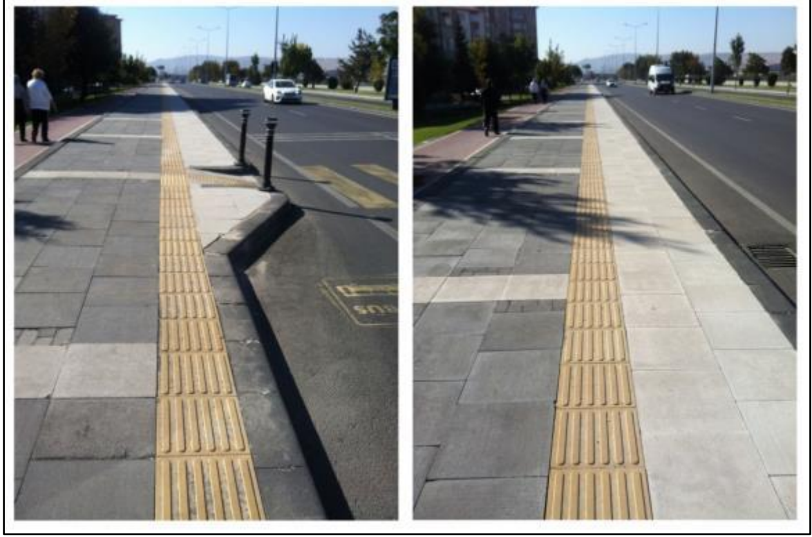
Resim 4.7. Sivas Belediyesi tarafından yapılan beton malzemeden kılavuz iz uygulaması (yazarın arşivinden)
