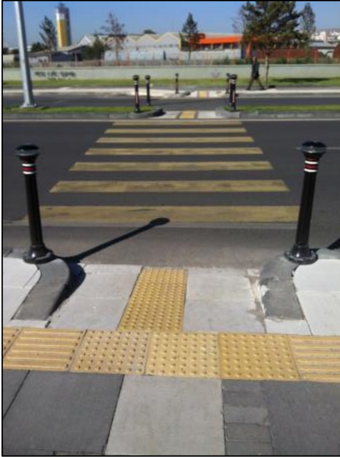
Resim 4.12. Sivas Belediyesi yaya geçidinde hissedilebilir yüzey uygulaması (yazarın arşivinden)
