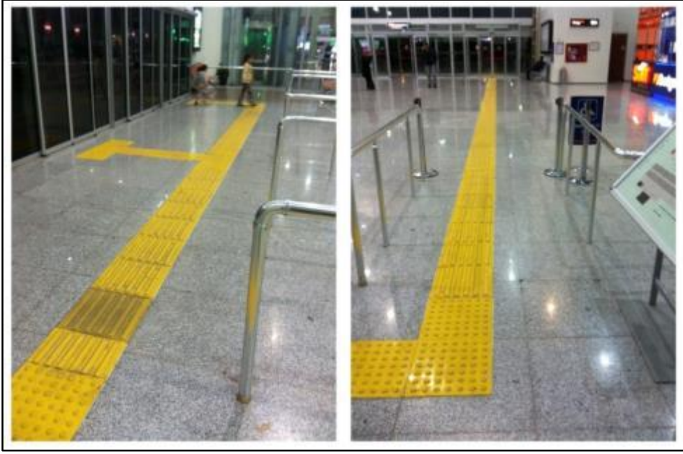
Resim 4.9. Sivas Havaalanında termo plastik poliüretan malzemeden kılavuz iz uygulaması (yazarın arşivinden)
