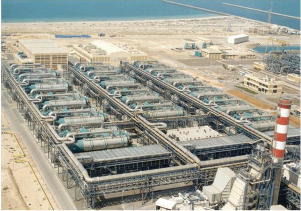
Resim 3. 1. Abu Dubai ters osmoz tesisi görüntüsü [35]
