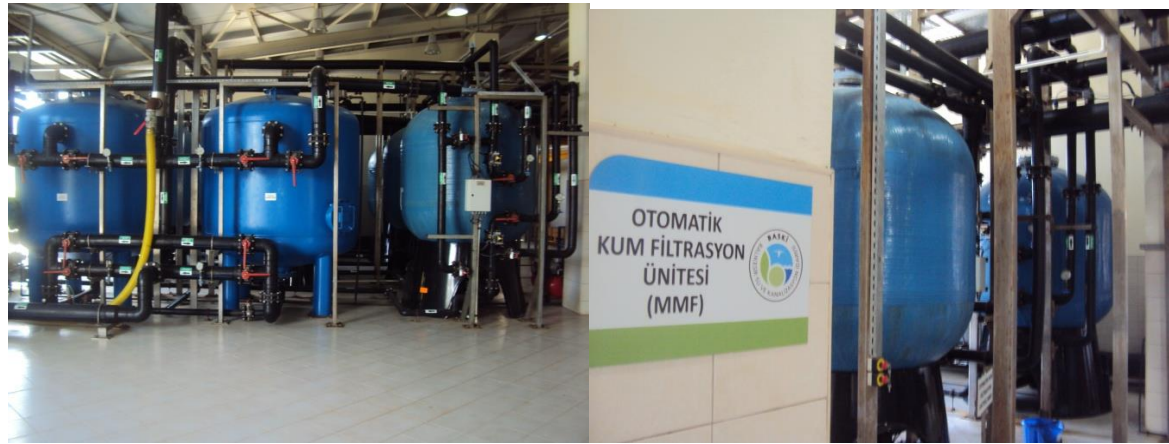
Resim 4. 9. Kum ve dolomit filtreleri
