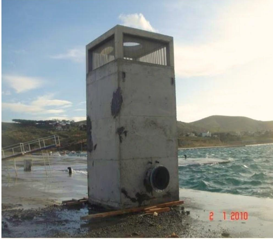
Resim 4. 4. Su alma yapısı (sahilde inşa edilip denize transfer edilmiştir) [61]
