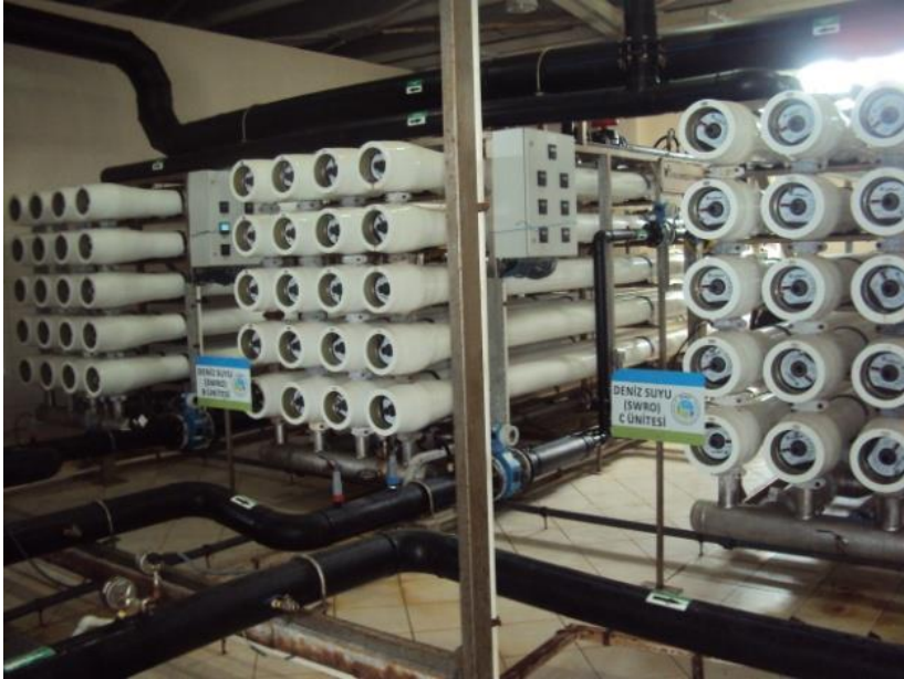
Resim 4. 13. Ters osmoz membranları genel görünümü
