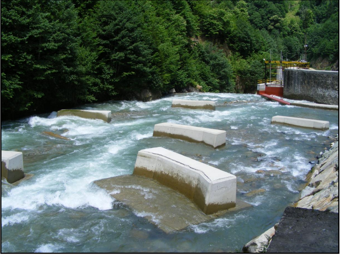
Resim 4.6. İkizdere regülatörü memba tarafı blokaj yapıldıktan sonra görünüşü
