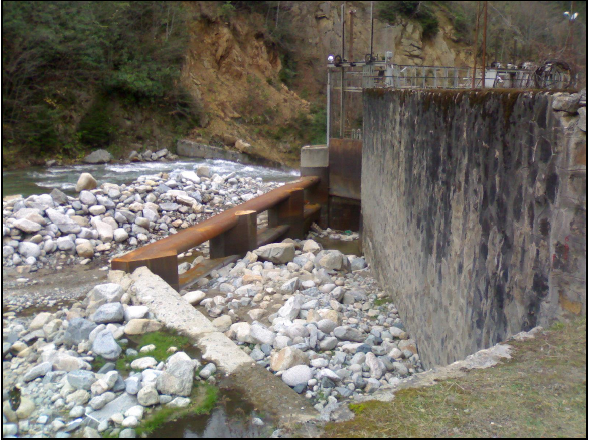
Resim 4.5. İkizdere regülatörü memba tarafı blokaj yapılmadan öncesi görünüşü
