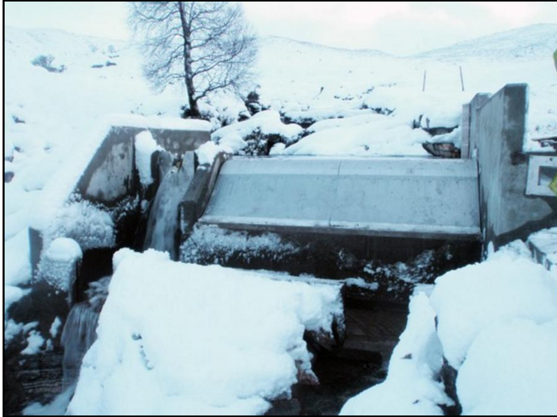
Resim 4.4. Kış mevsiminde işletmede olan bir coanda tipi su alma yapısı [25]
