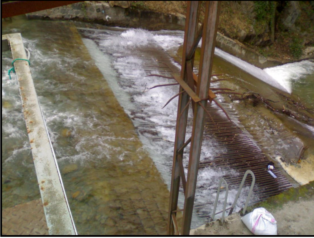
Resim 4.2. İkizdere regülatörü tirol tipi su alma yapısı
