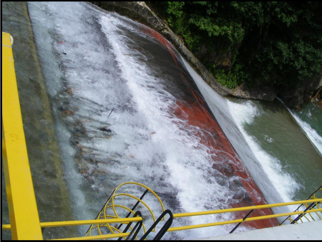
Resim 4.3. İkizdere regülatörü tirol tipi su alma yapısında akış düzeni bozulması
