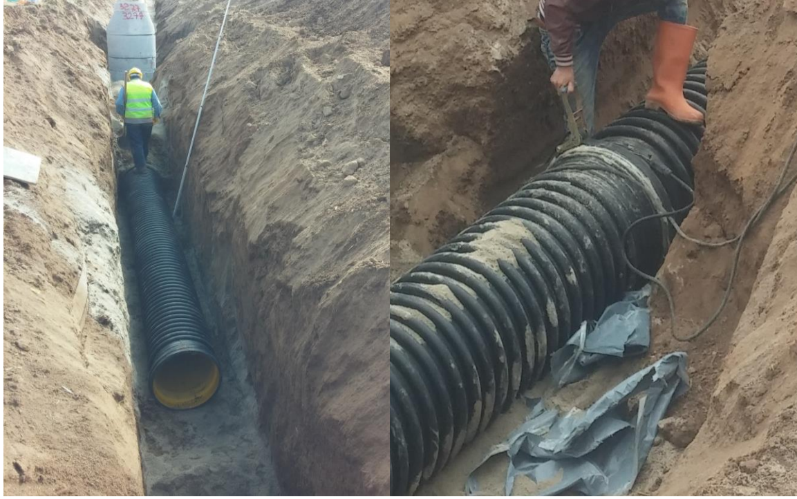
Resim 3.3. Spiral sarımlı koruge borunun hendeğe konulması ve döşenmesi
