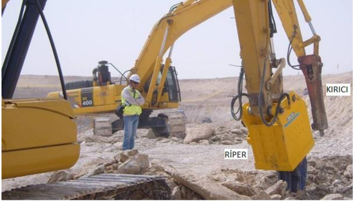
Resim 2.2. Sert zemin kazılarında kullanılan makine ekipmanları
