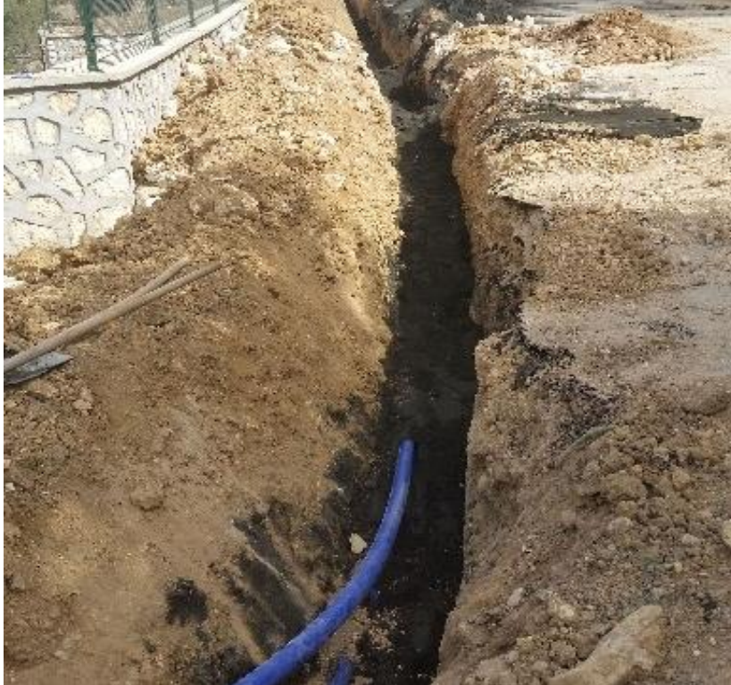
Resim 2.7. İçme suyu borusu döşenen hendek
