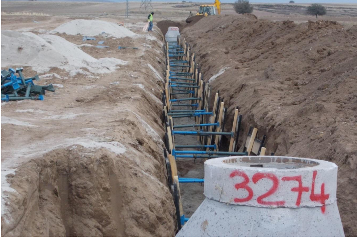
Resim 2.3. Aralıklı ahşap iksa uygulaması ile açılan hendek
