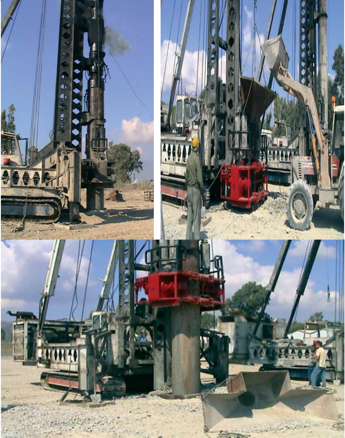
Resim 3.4. Taş Kolon Uygulaması
