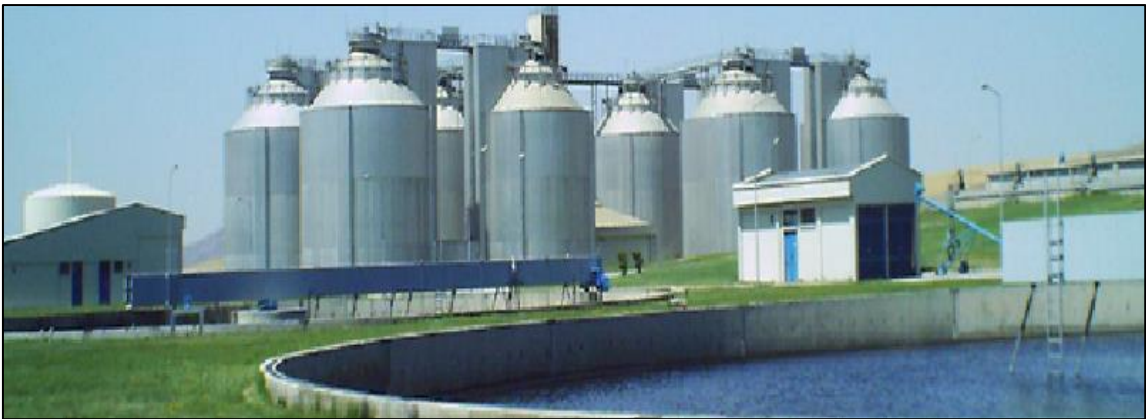
Resim 2.14. Atıksu arıtma çürütücü (digestor) tanklar [5]
