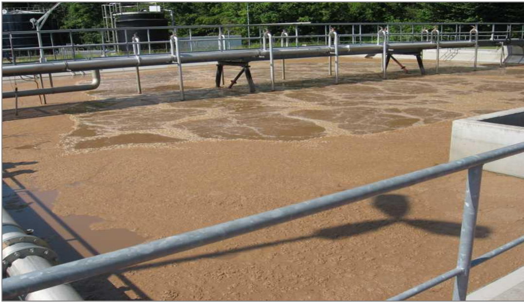
Resim 2.15. Atıksu arıtma havalandırma havuzu [7]
