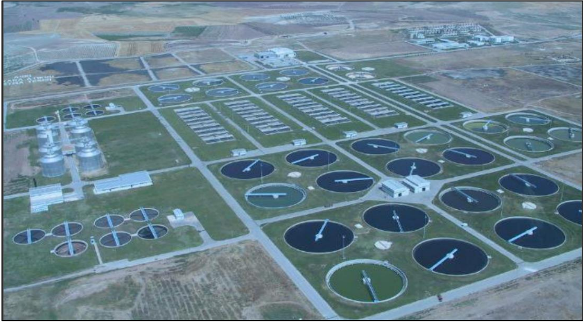
Resim 2.1. Ankara merkezi atıksu arıtma tesisi [5]
