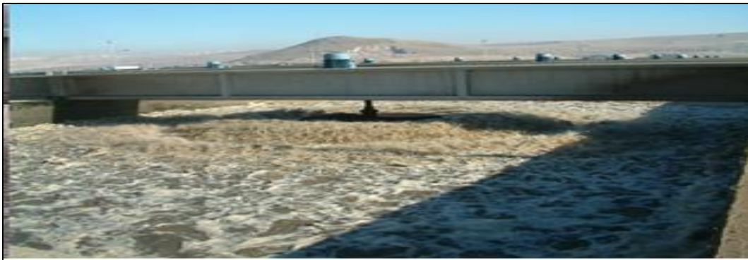
Resim 2.6. Atıksu arıtma dengeleme üniteleri [5]
