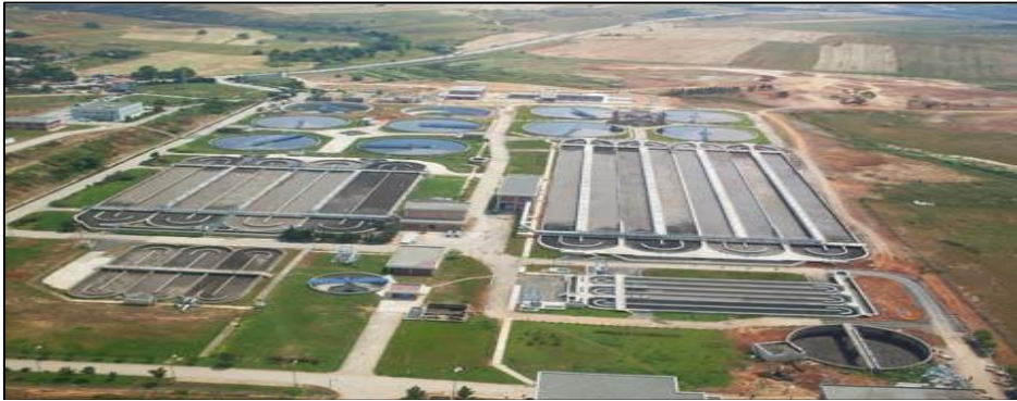
Resim 2.16. İstanbul paşaköy ileri biyolojik atıksu arıtma tesisi [5]
