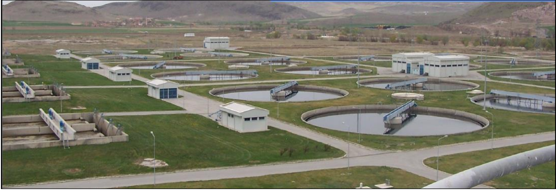
Resim 2.13. Atıksu arıtma son çökeltme havuzları [5]
