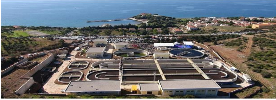
Resim 2.17. İzmir doğanbey-ürkmez ileri biyolojik atıksu arıtma tesisi biyolojik azot ve fosfor giderim havuzları [5]
