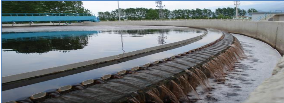
Resim 2.7. Atıksu arıtma ön çökeltme havuzu [5]
