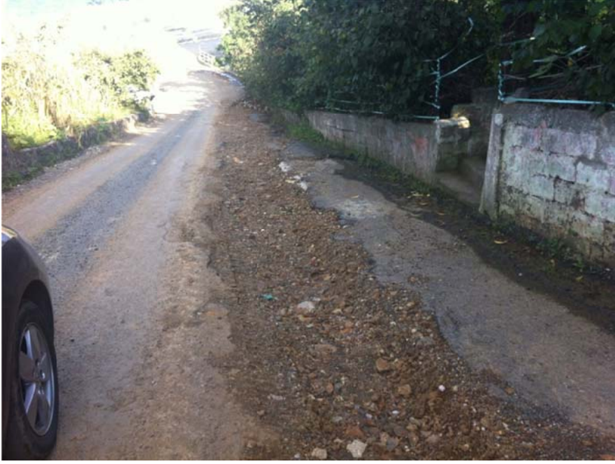
Resim 4.5. Kanalizasyon inşaatında kullanılan stabilize malzeme
