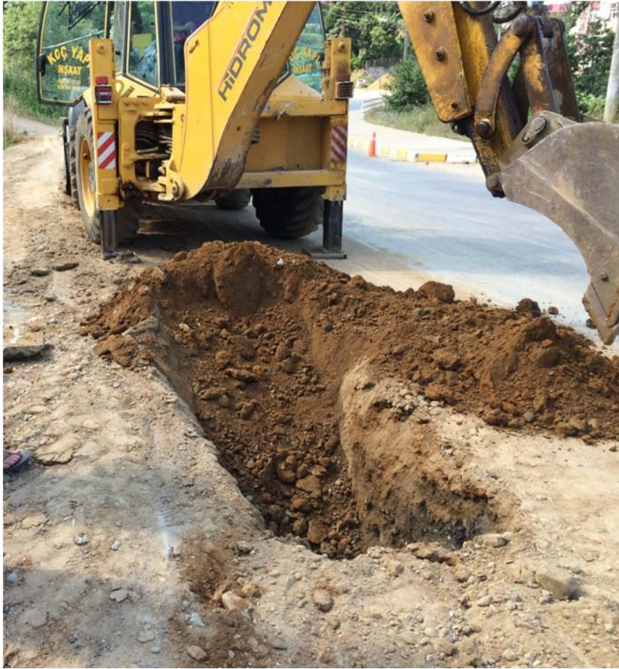
Resim 4.6. Kanalizasyon inşaatında kullanılan stabilize malzeme
