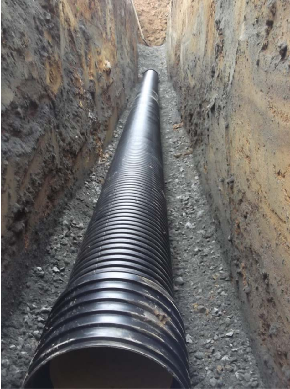
Resim 4.4. Kanalizasyon borusu yatakalama-gömlekleme
