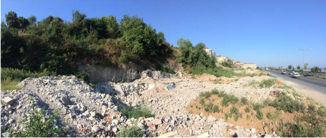
Resim 3.5. Pelitli (Trabzon) Kentsel Dönüşümü kapsamında yapılan kontrolsüz yıkım
