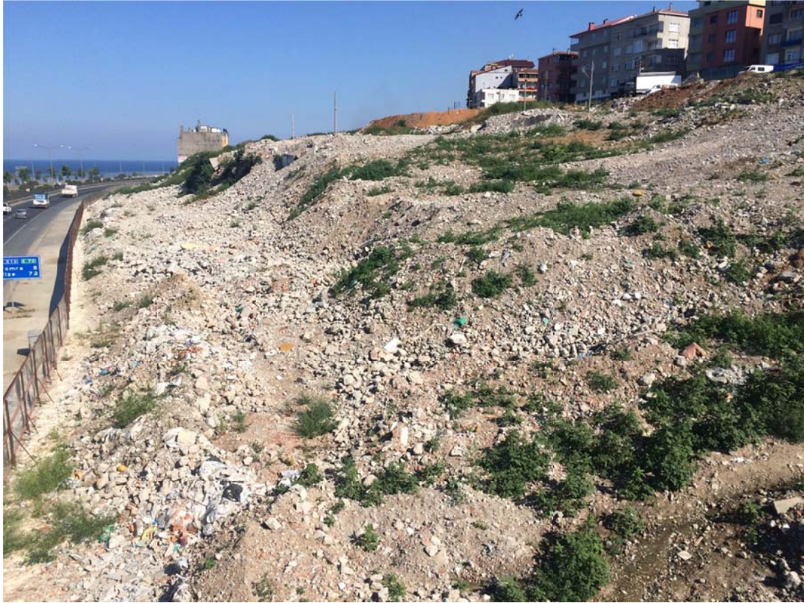
Resim 3.4. Hafriyat ve yıkıntı atıklarının birbirine karıştırılması
