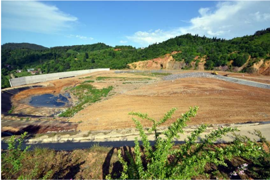
Resim 3.2. Çamburnu (Trabzon) katı atık depolama tesisi [10]
