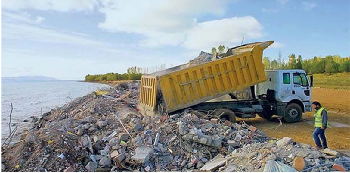
Resim 4.2. İYA'nın ayrıştırılmadan dolguda kullanılması [21]
