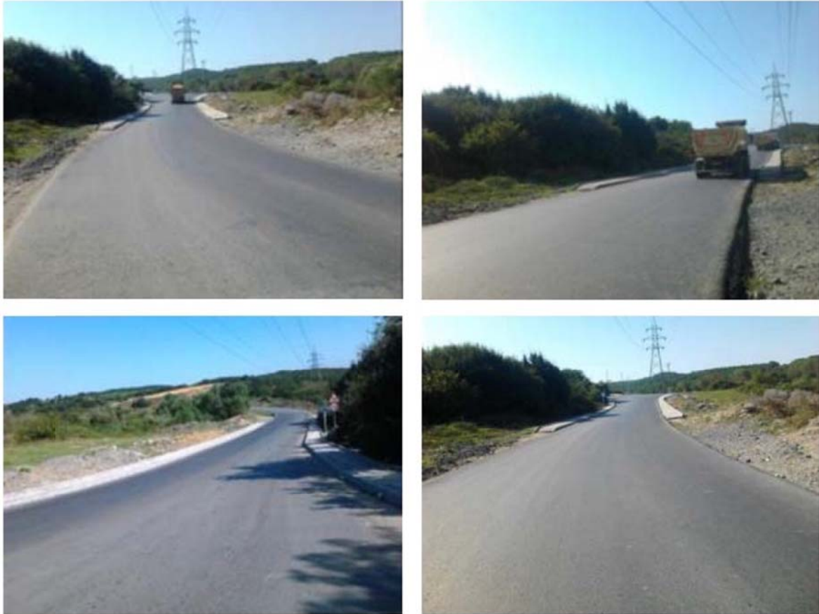
Resim 4.3. İYA kullanılarak yapılan deneme yolu [1]
