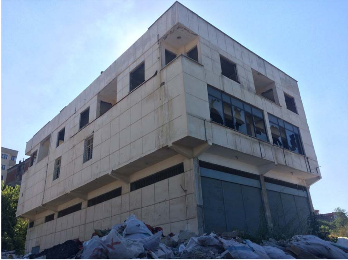
Resim 3.3. Seçici yıkım öncesi sökümü yapılmış bir bina
