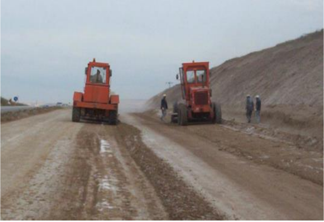
Resim 4.3. Greyder ile karıştırma (Kavak ve diğlerleri, 2008:12)
