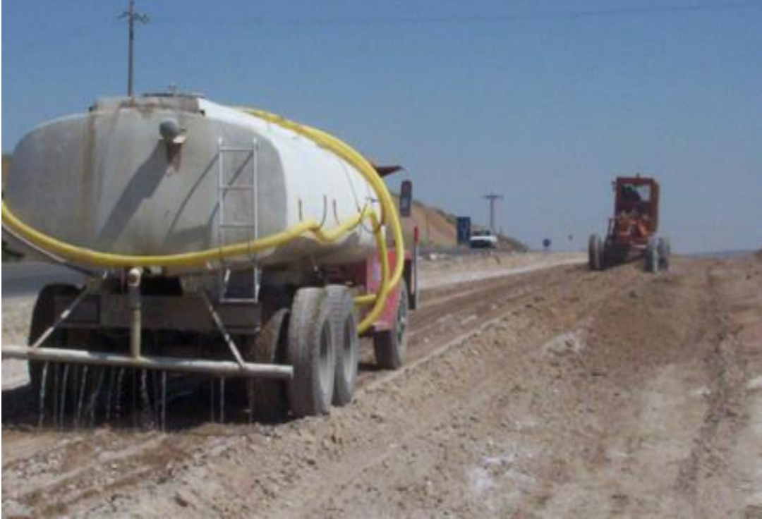
Resim 4.4. Kireçli karışımın sulanması (Kavak ve diğlerleri, 2008:12)
