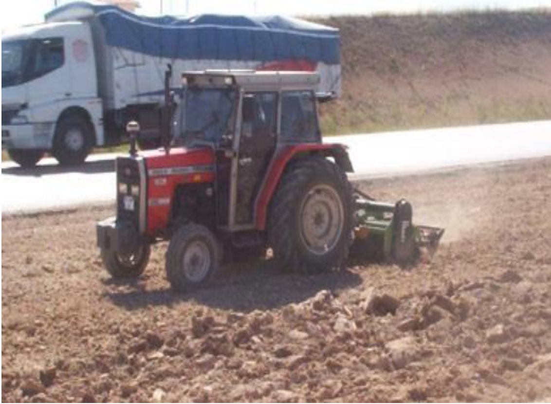
Resim 4.1. Rotil ile karıştırılan zemin (Kavak ve diğerleri, 2008:4)
