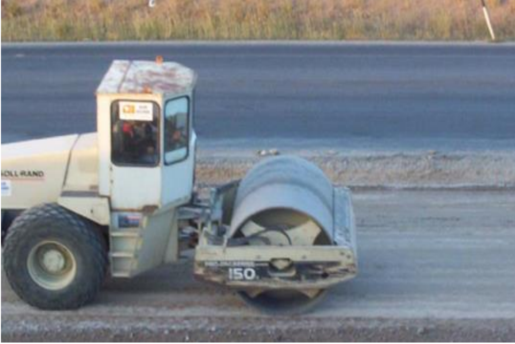
Resim 4.5. Silindir ile sıkıştırma (Kavak ve diğerleri, 2008:13)
