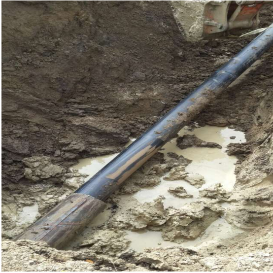
Resim 2.10 - Çelik klavuz boru içinde HDPE boru ile yatay delgi uygulaması fotoğrafları
