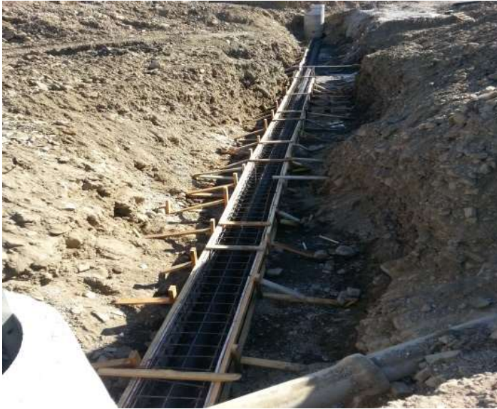
Resim 2.9 – Yerde beton döküm dere geçişi fotoğrafı
