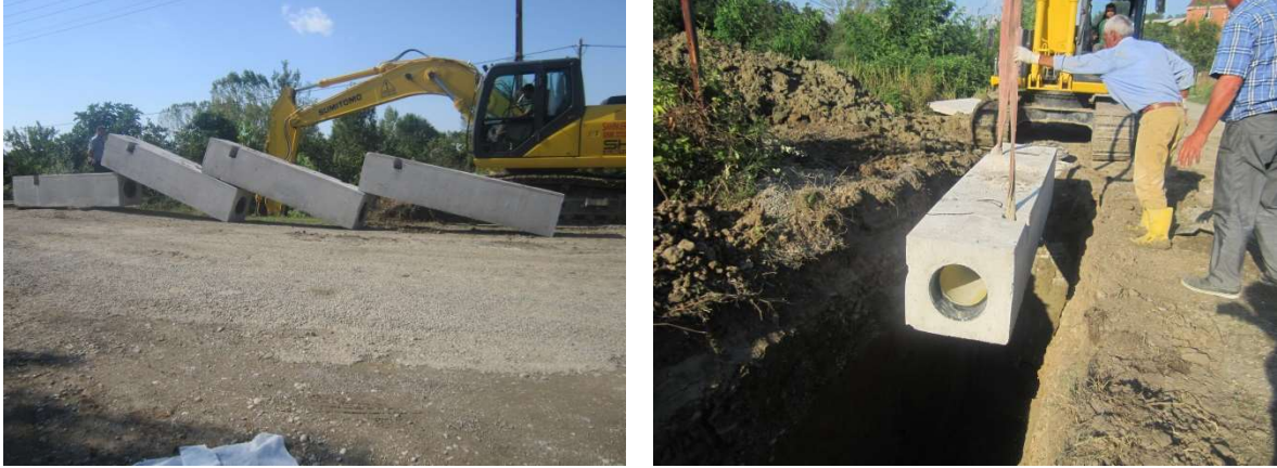
Resim 2.8 – Prefabrik beton gömlek dere geçiş elemanı fotoğrafları
