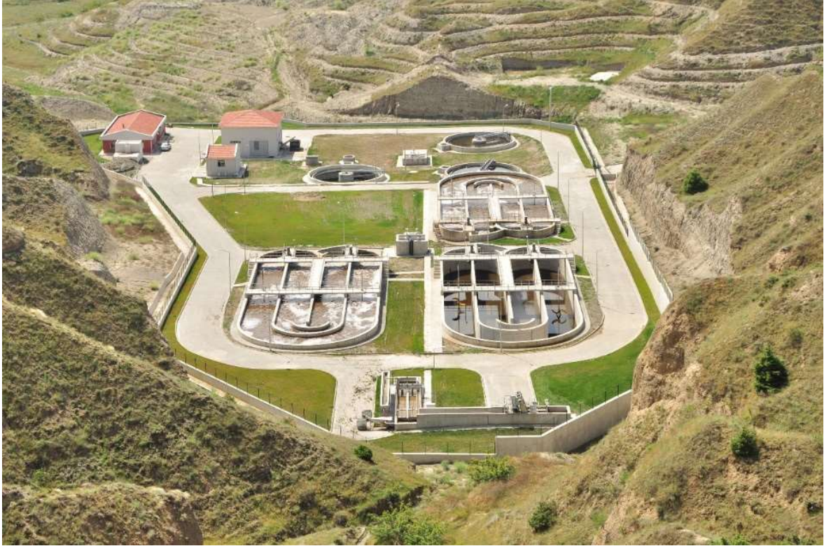
Resim 2.21 – Tosya(Kastamonu) atıksu arıtma tesisi fotoğrafı
