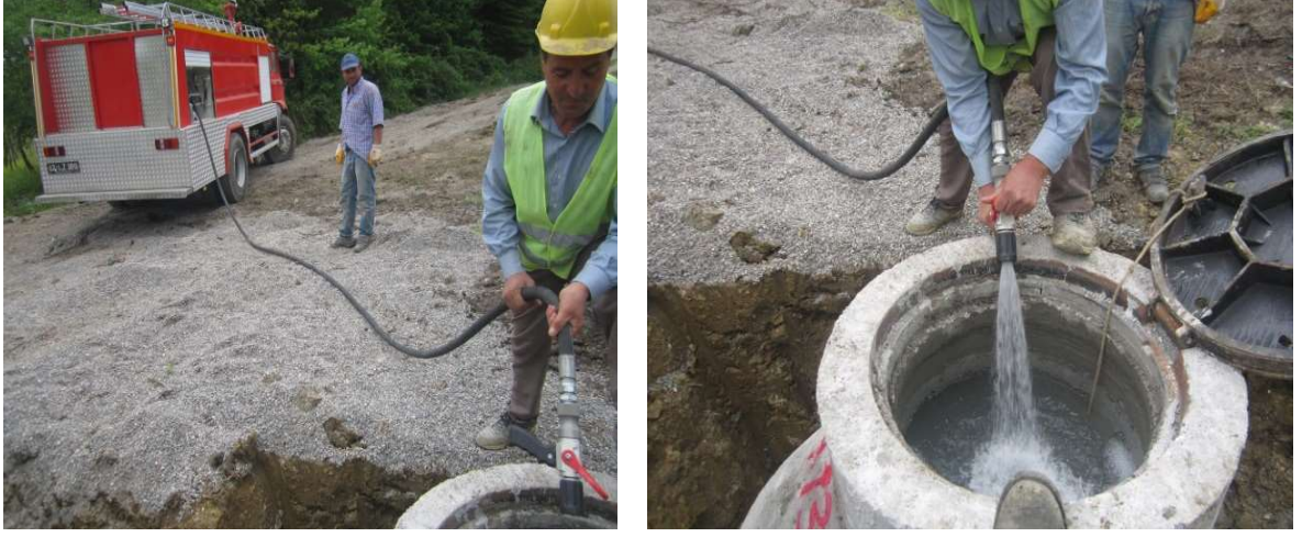
Resim 2.13 – Sızdırmazlık testi uygulama esnasındaki fotoğraflar
