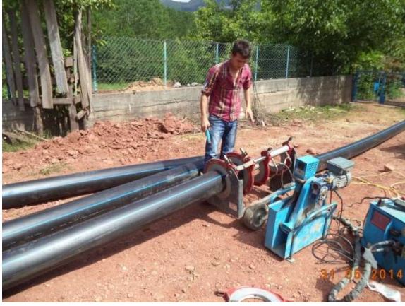
Resim 2.19 - Alın kaynağı ile HDPE boru birleştirme fotoğrafı
