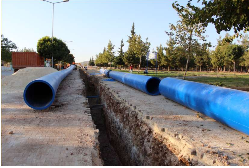
Resim 2.15 – Kilis içmesuyu inşaatına ait fotoğraf
