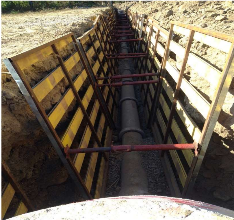
Resim 2.1 – Hasankadı (Bartın) kanalizasyon inşaatı hendek kesiti
