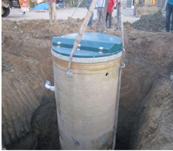
Resim 2.7 – Paket terfi uygulamasına ait fotoğraflar
