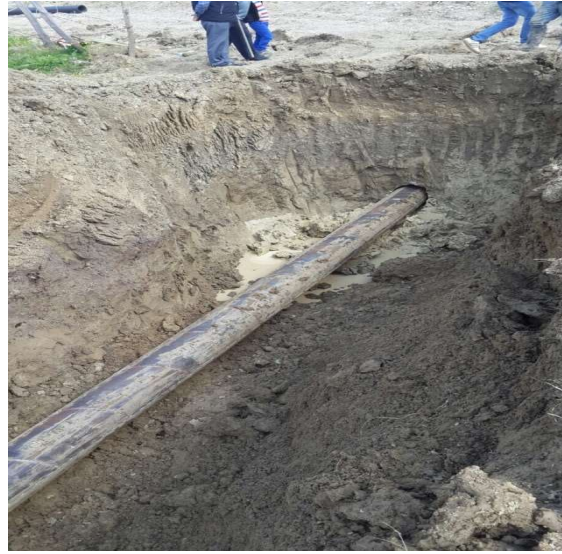
Resim 2.10 - Çelik klavuz boru içinde HDPE boru ile yatay delgi uygulaması fotoğrafları
