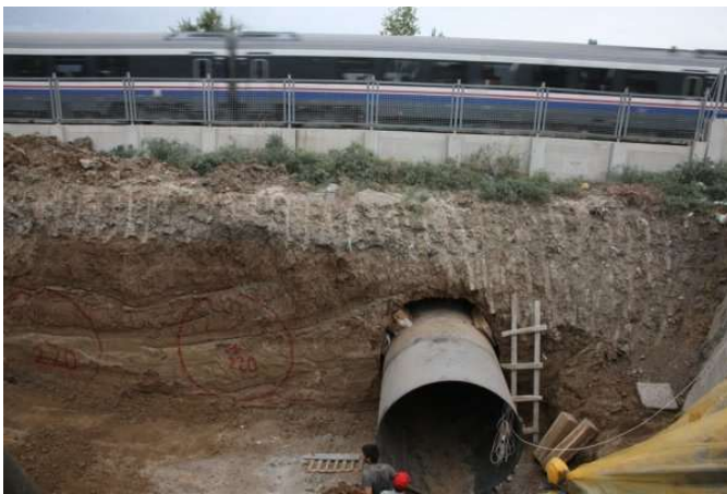
Resim 2.11 – Yatay delgi metodu ile demiryolu geçişi uygulaması fotoğrafı
