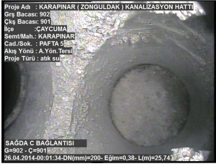
Resim 2.14 – Kanalizasyon görüntü örneği fotoğrafı
