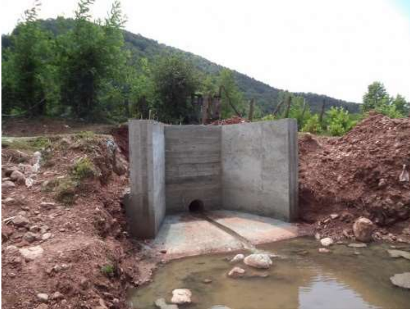
Resim 2.12 – Deşarj yapısı uygulaması fotoğrafı
