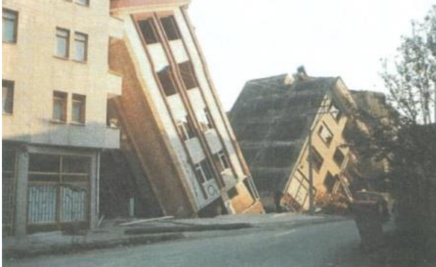
Resim 3.5. 1999 Yılında Adapazarı Depreminde Sıvılaşma Sonucu Devrilen Binalar
