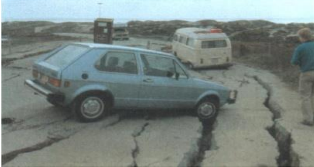
Resim 3.3. 1989 yılında LomaPrieta Depreminde Meydana Gelen Yanal Yayılma
