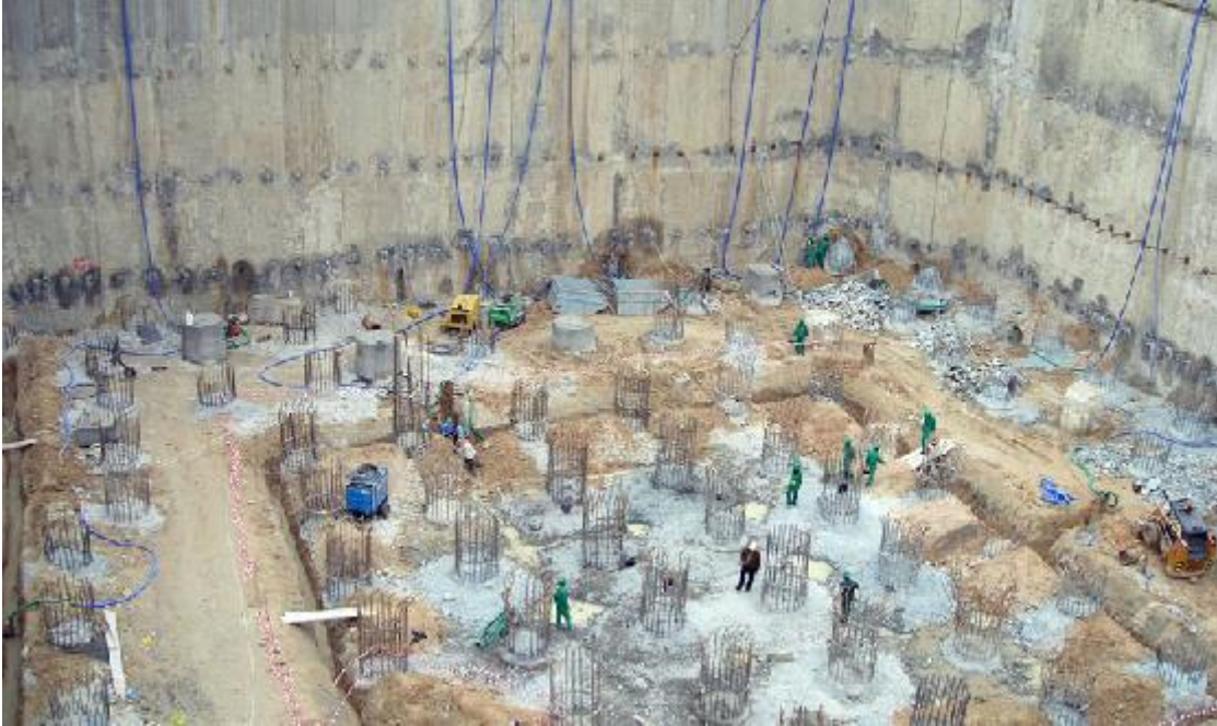
Resim 4.8. Diyafram duvar ile güvenli çalışma [40]
