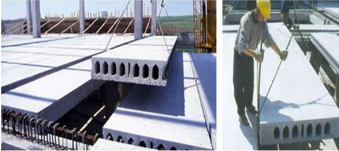
Resim 4.1. Boşluklu-kirişli döşeme uygulaması [35]
