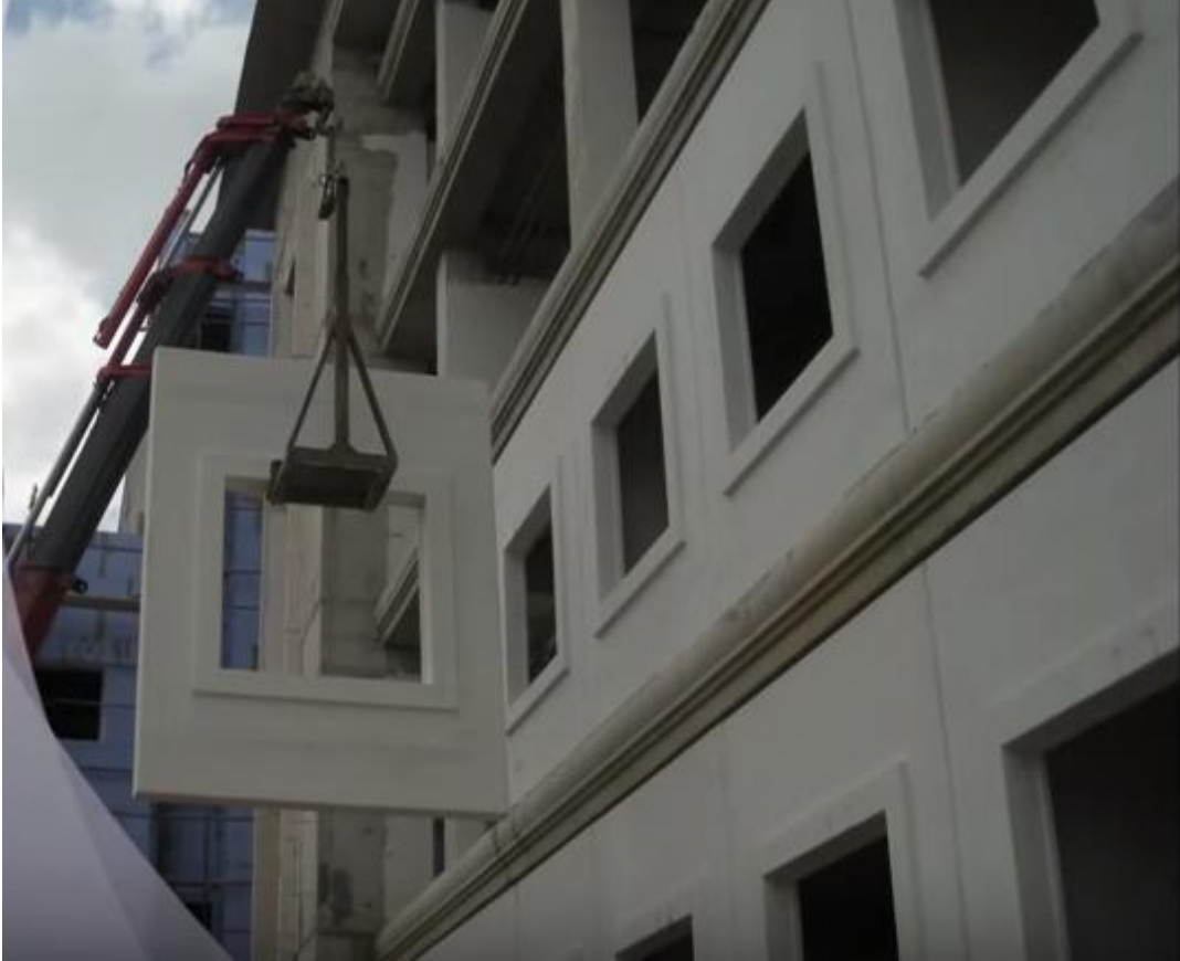
Resim 4.2. Precast beton duvar yapımı [36]
