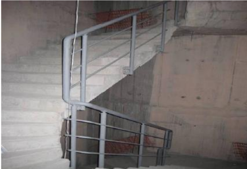
Resim 4.9. Kalıcı korkulukların betonarme ile beraber imalatı [17]
