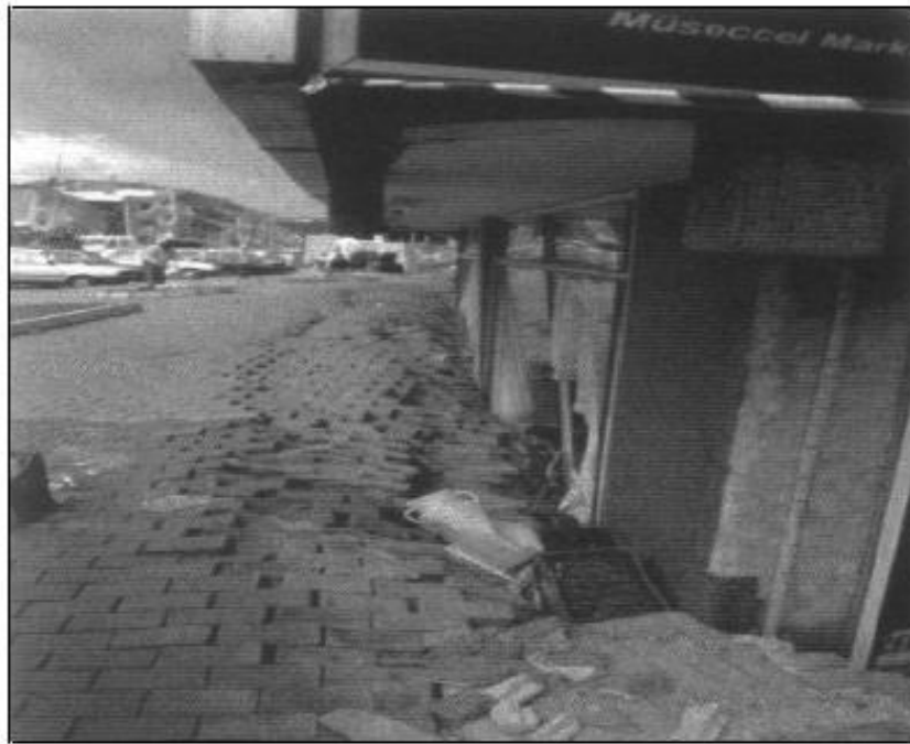
Şekil 3.6. Zımbalama göçmesi örneği (Çinicioğlu, 2005).
