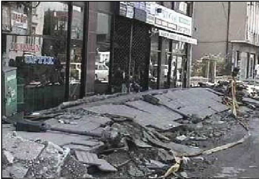
Şekil 3.3. Meydana gelen kayma göçmesi örneği
