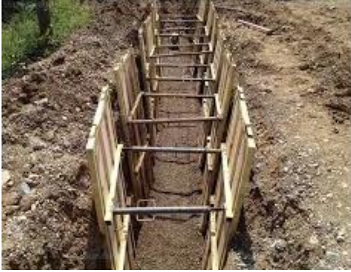
Resim 8.4. Değişik tipte yapılmış ahşap iksa
