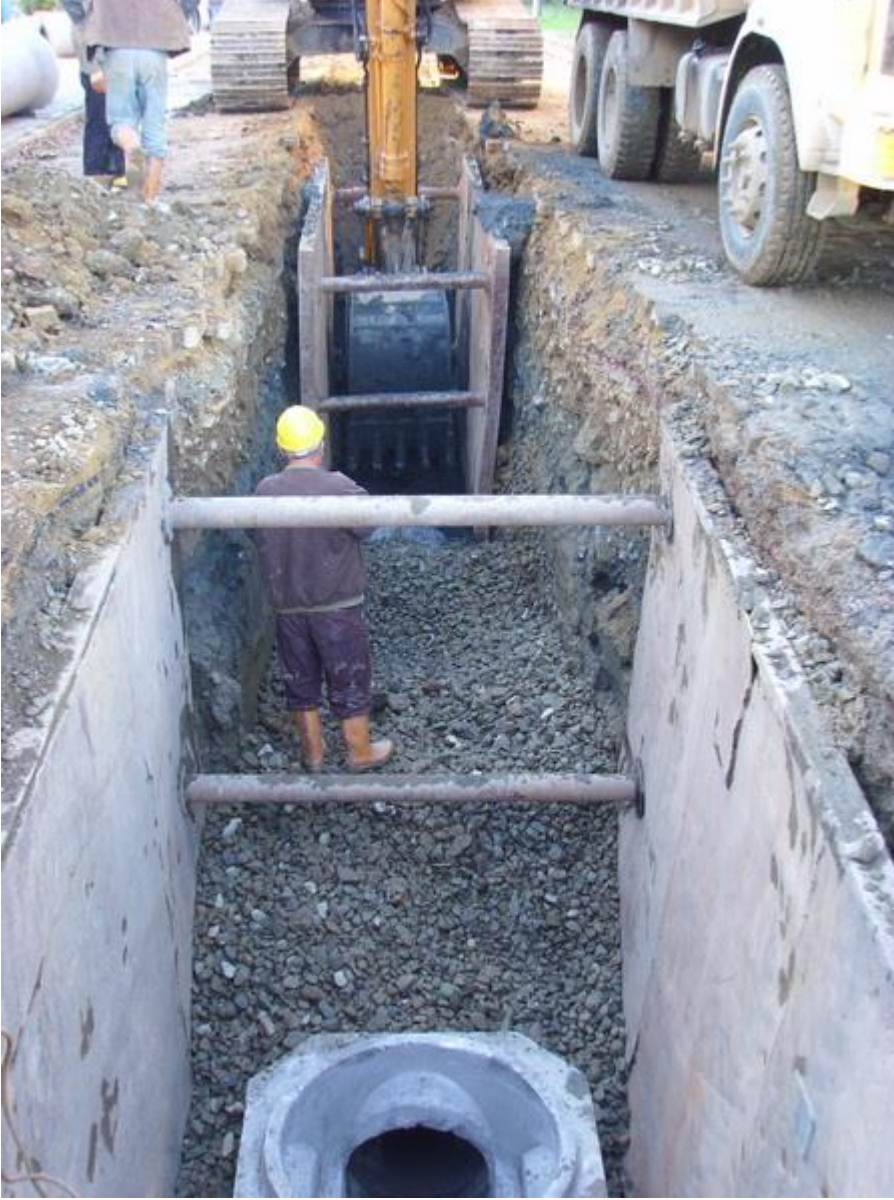
Resim 8.6. Farklı şekillerde yapılan çelik pano iksa örneği
