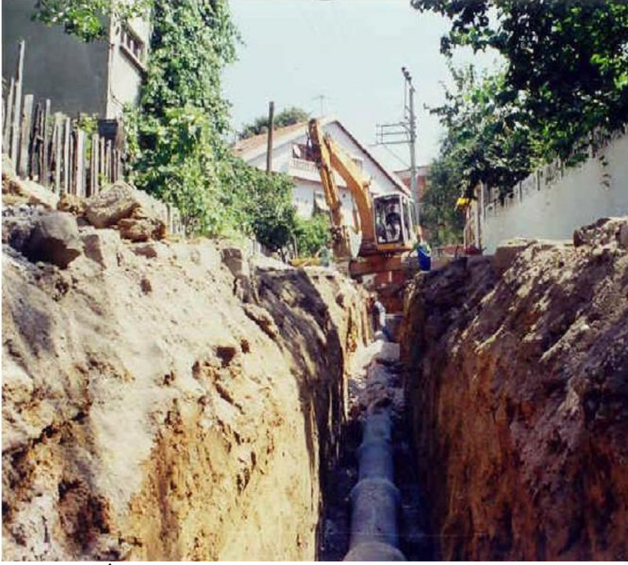
Resim 8.5. İksasız ve şevsiz hendekte çalışan işçi[32].
