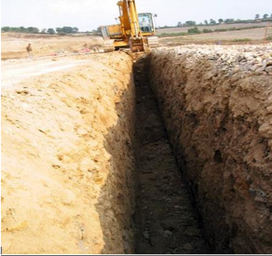
Resim 8.1. Kazısı yapılmış hendekten sonra iksa yapımı aşaması[31].
