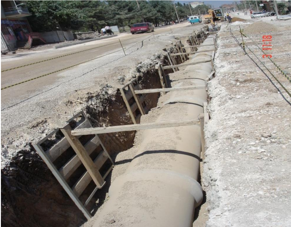
Resim 8.3. Değişik tipte yapılmış ahşap iksa
