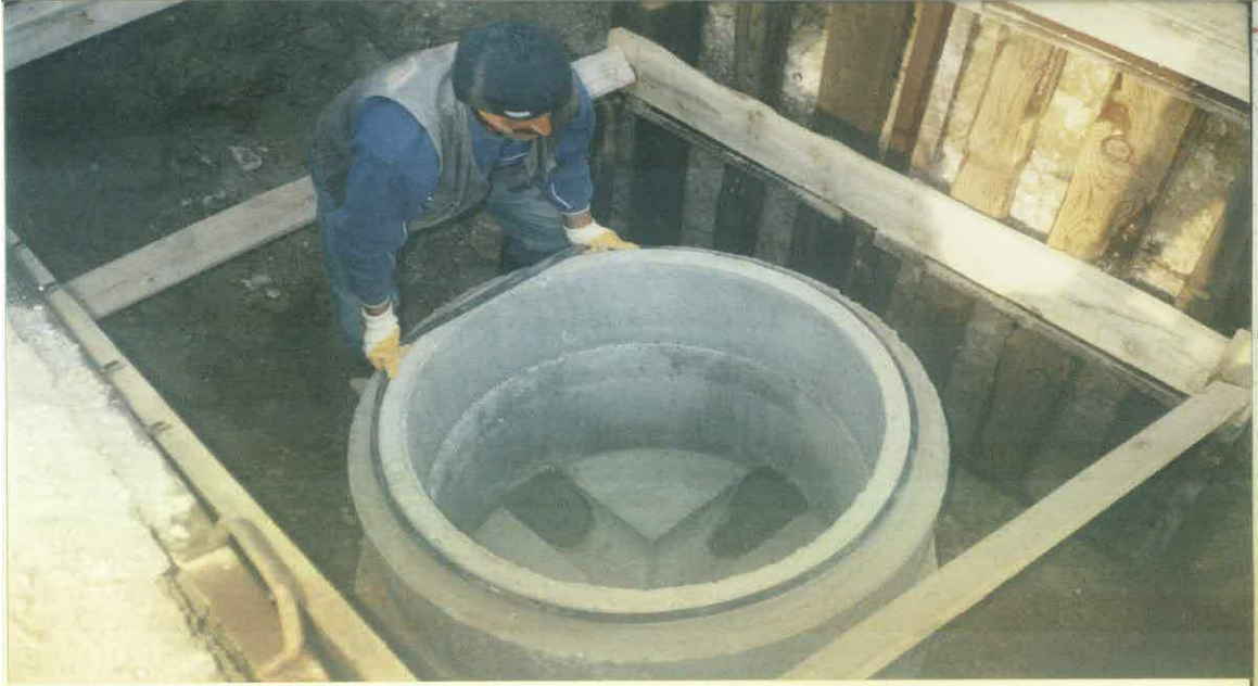
Resim 6.1. Tam kaplamalı ahşap iksa
