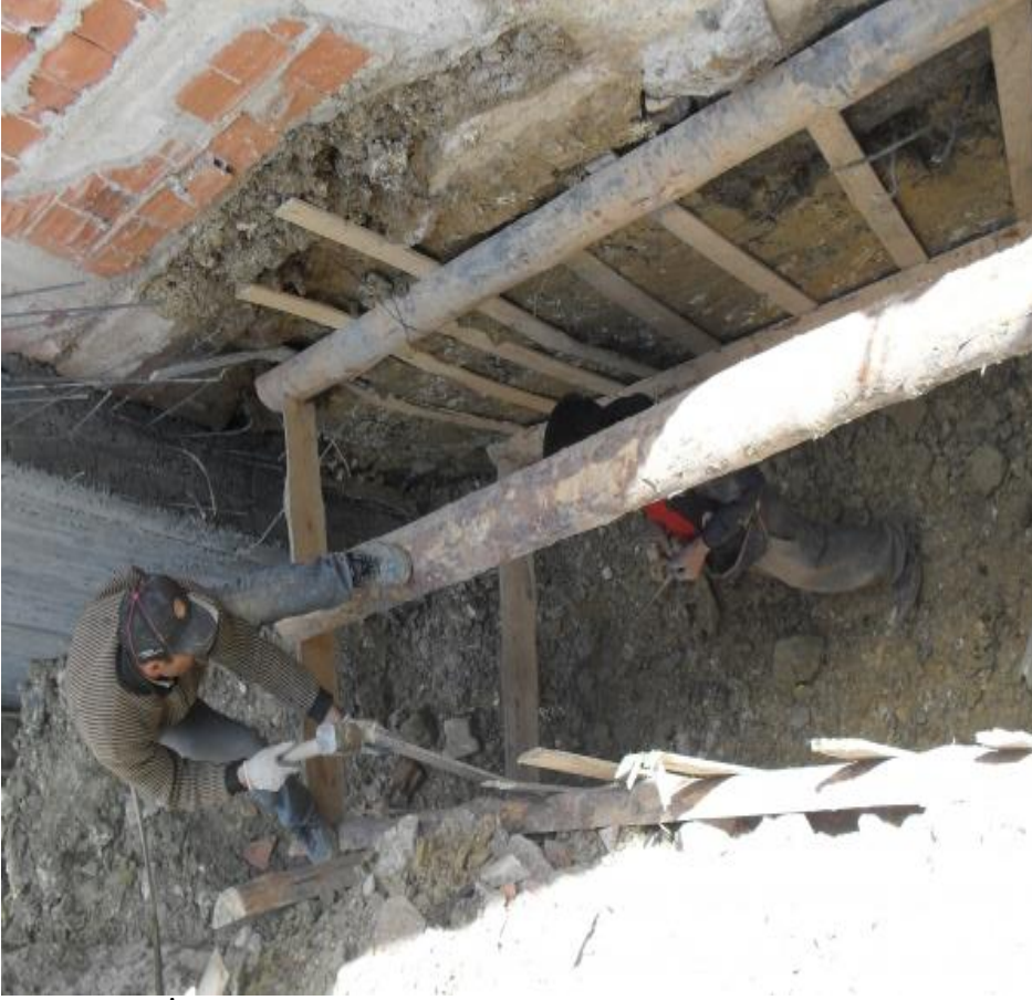
Resim 8.2. İksa yapımında çalışan işçiler
