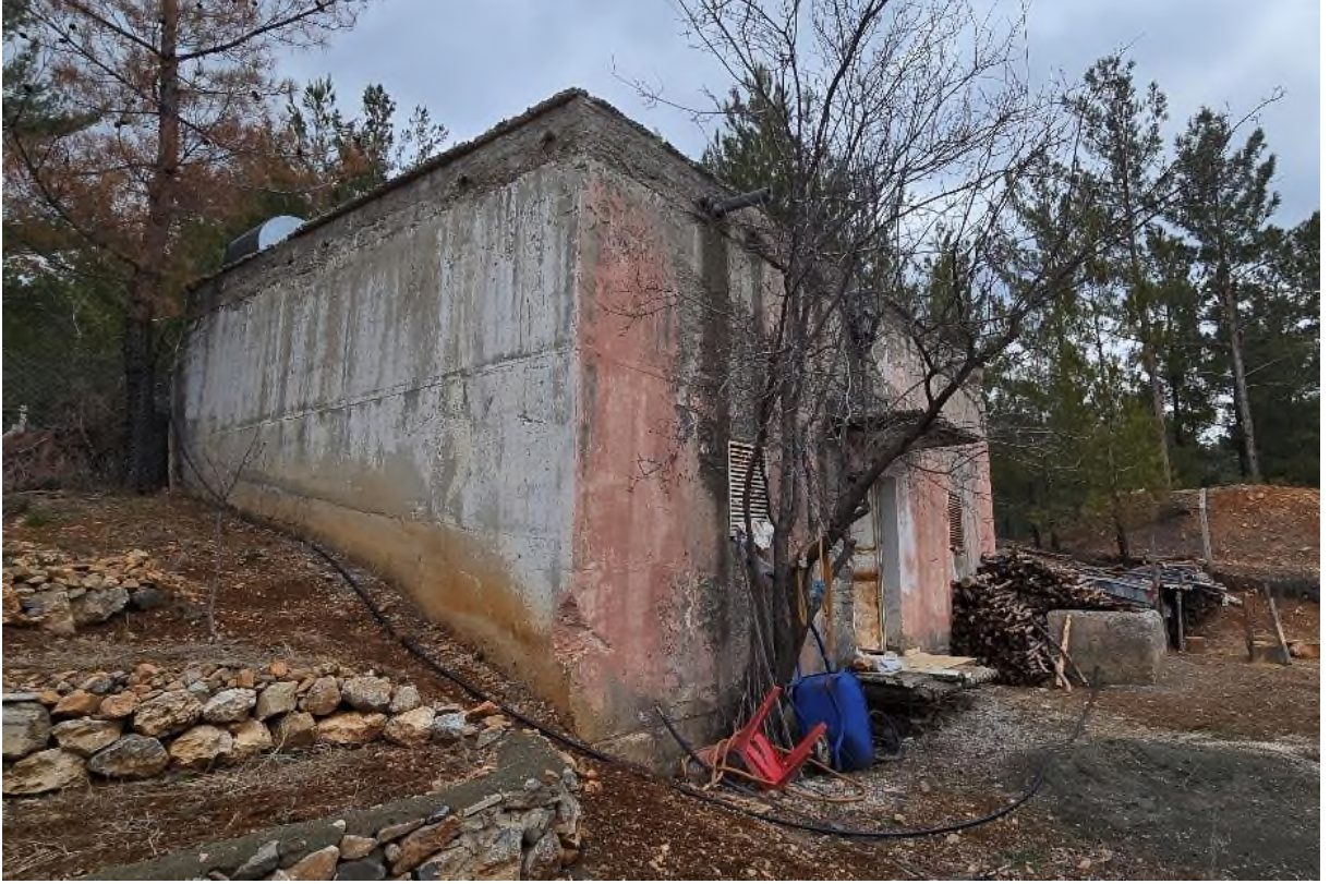
Mevcut DT1 Toplama Deposu
