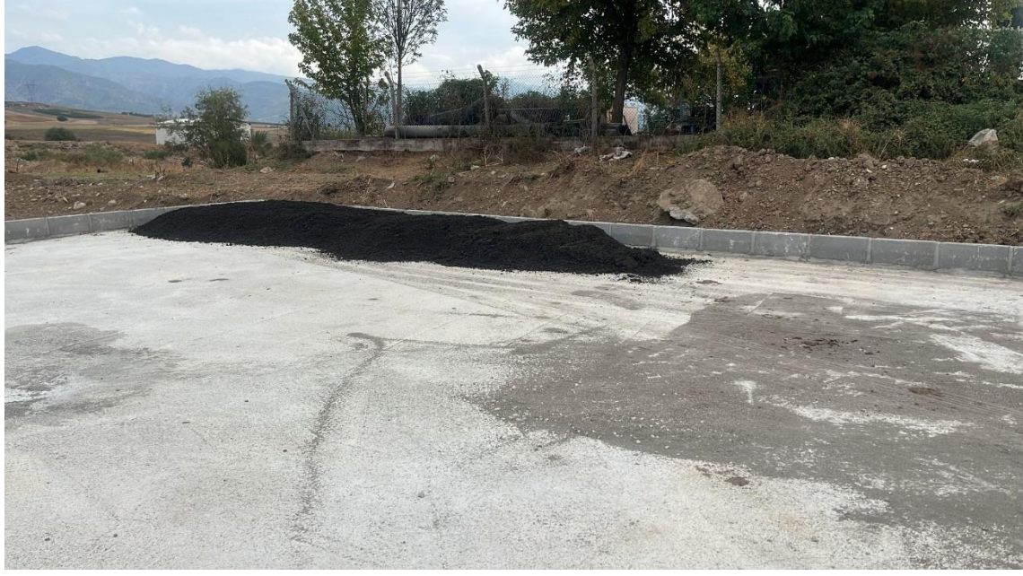
Alt Proje Alanındaki Atık Çamur Geçici Depolama Alanı
