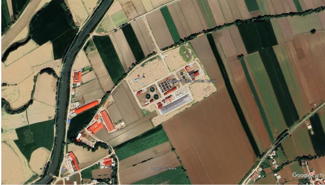
Şekil 1. Elbistan'ın Mevcut Atıksu Arıtma Tesisi
