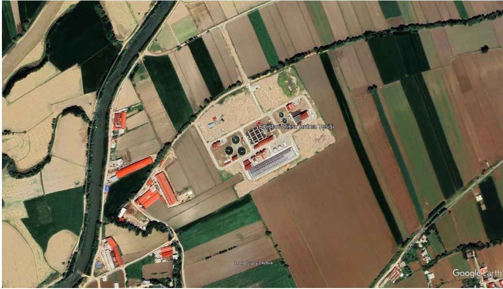
Şekil 1. Elbistan'ın Mevcut Atıksu Arıtma Tesisi
