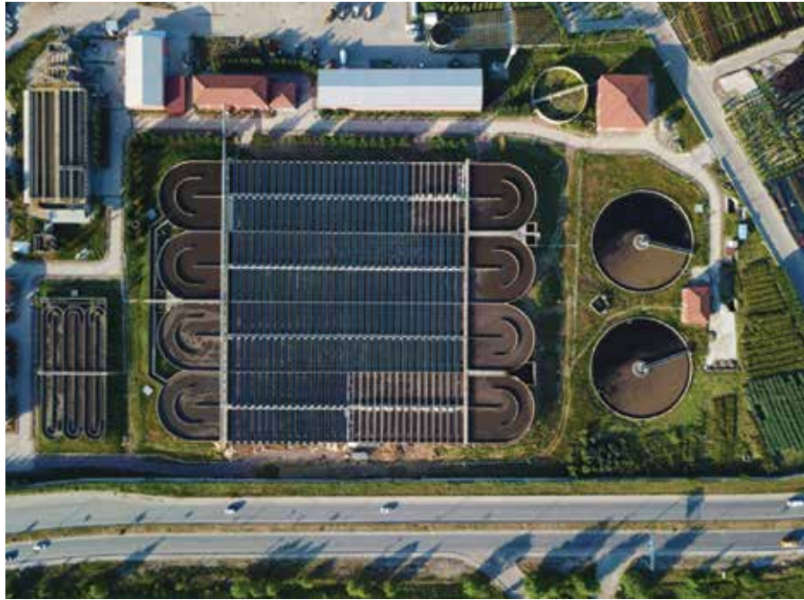
Yalova Atık Su Arıtma Tesis
