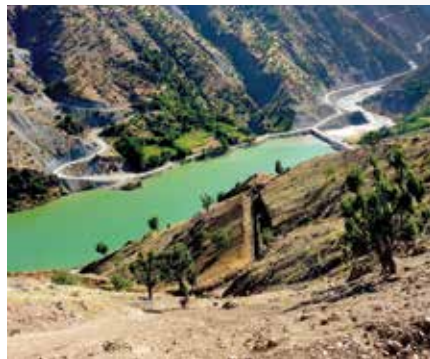
Adıyaman Sincik İçmesuyu İkmal İnşaatı
