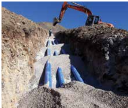
Niğde Ulukışla İçmesuyu İnşaatı
