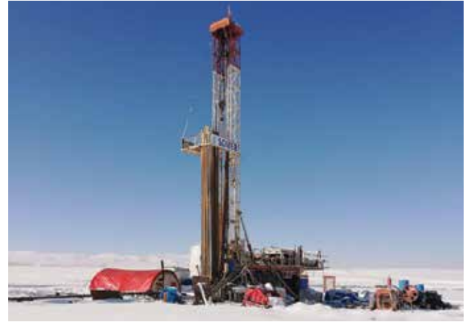
Ağrı Taşlıçay Jeotermal Sondaj Çalışması
