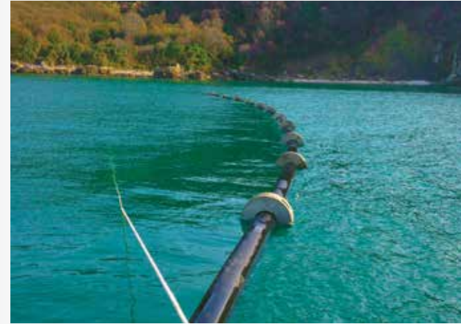
Bartın Amasra Derin Deniz Deşarjı İnşaatı
