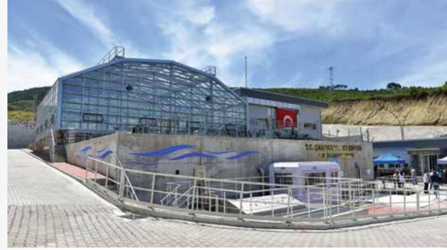
Çanakkale Dardanos-Güzelyalı Atık Su Arıtma Tesisi
