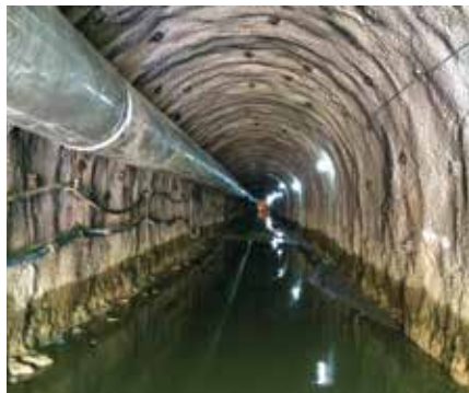
Bolu Karadere İçmesuyu Temini Projesi
