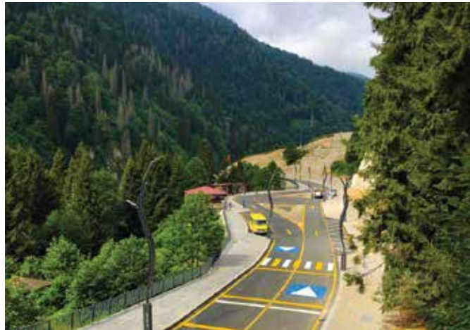
Rize Ayder Yol ve Altyapı Çalışması
