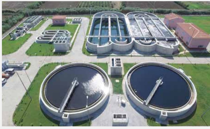
Samandağ (HATAY) Atıksu Arıtma Tesisi
