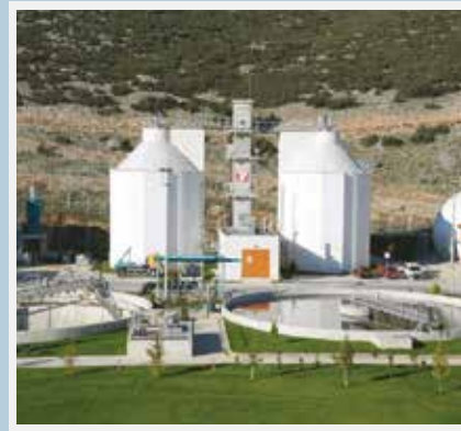
Muğla Atıksu Arıtma Tesisİ
