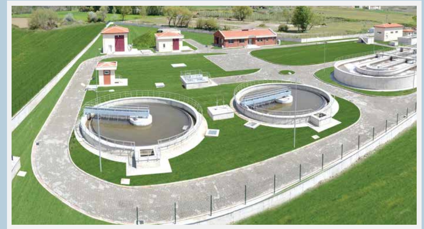
Çorum / İskilip Atıksu Arıtma Tesis
