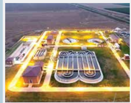
Reyhanlı (HATAY) Atıksu Arıtma Tesisi
