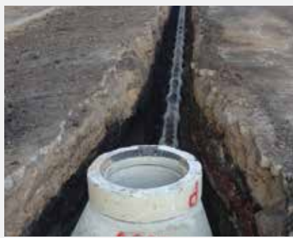
Çan Kanalizasyon Yağmursuyu Projesi
