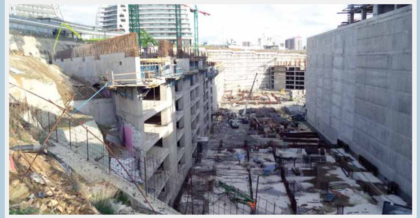
İstanbul Uluslararası Finans Merkezi (İUFM) ortak altyapı inşaatı
