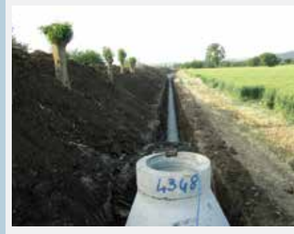
Yarbaşı-Ellek- Atalan Grup Knl İnşaatı
