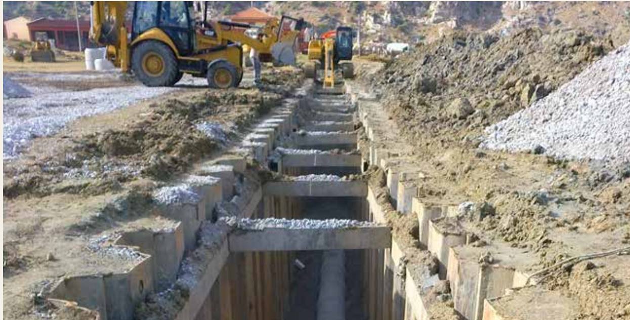
Aydın / Sazlı, Kanalizasyon İnşaatı
