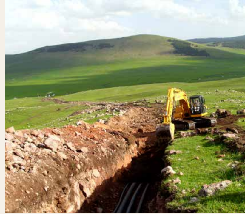
Ardahan / Köprülü, İçmesuyu İnşaatı
