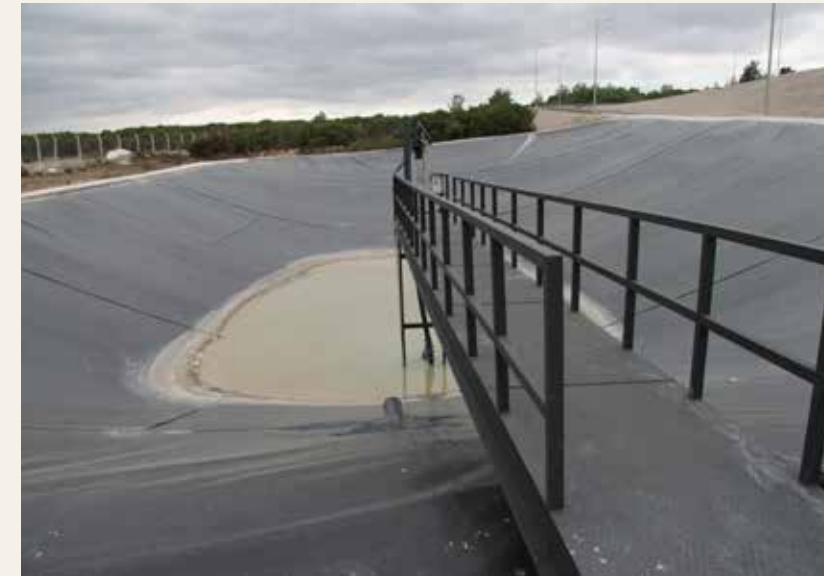
İzmir/ Bergama, Katı Atık Tesisi
