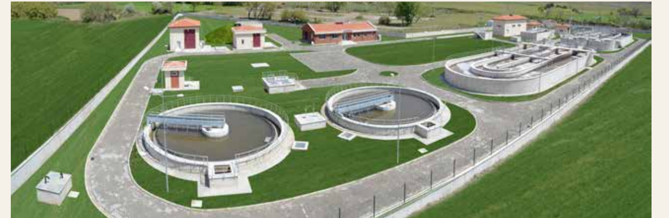
Çorum/İskilip, Atıksu Arıtma Tesisi
