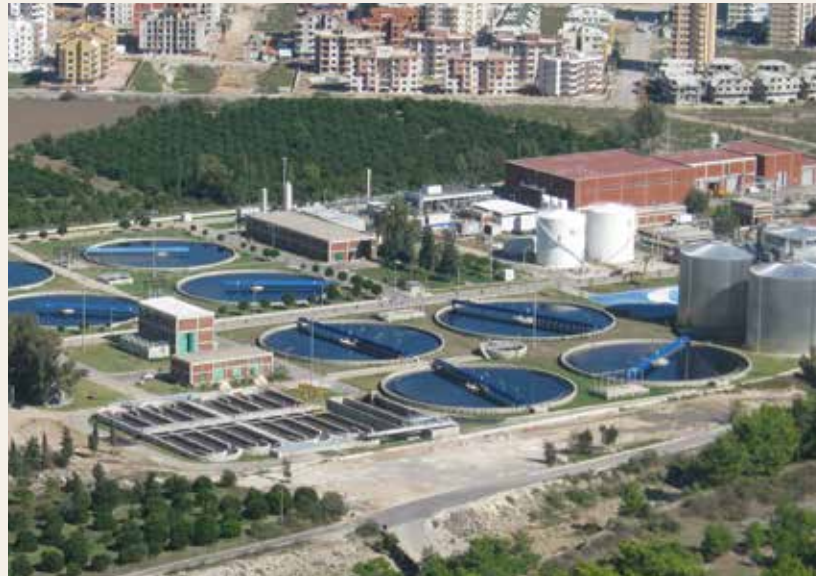
Antalya Hurma Atıksu Arıtma Tesisi
