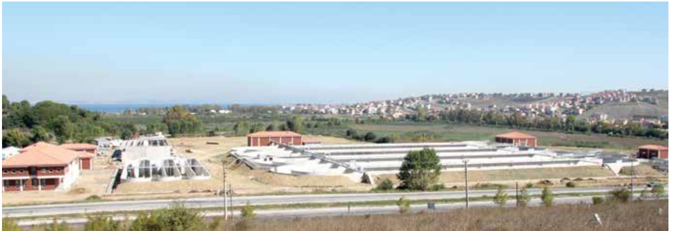
Yalova İleri Biyolojik Atıksu Arıtma Tesisi
