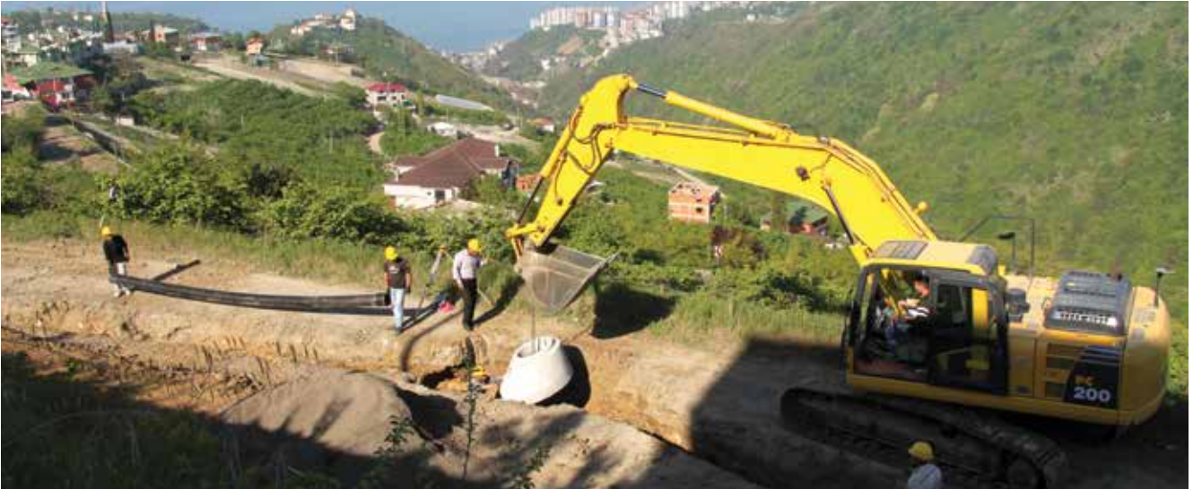
Trabzon, Akyazı Gürbulak Kanalizasyon İnşaatı İş
