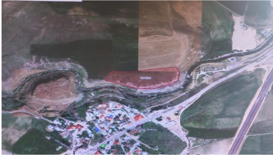
Resim 2. Hamur Belediyesi Güneş Enerji Santrali Proje Sahası
